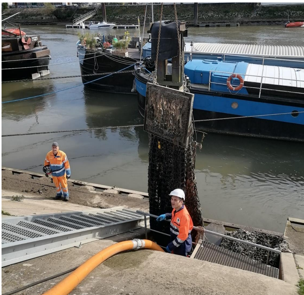
625 Figure 11 : Double filet anti-macrodéchets disposé sur un DO par Pollustock® à Rouen, 626 Avril 2022. Noter la forte présence visuelle de lingettes dans le filet, caractéristique des DO.
