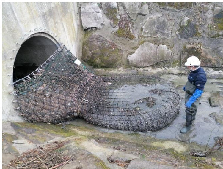
Figure 10 : Filet anti-macrodéchets disposé sur un émissaire d'eau pluvial par Pollustock® à Goussainville, janvier 2021.
