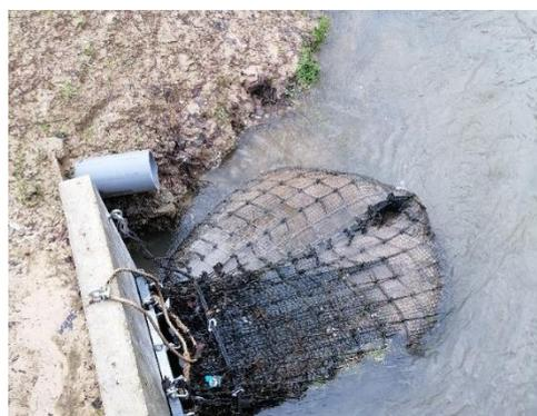
**Photo 1** : Filet anti-macrodéchets installé à Malaunay par Pollustock en 2021. Un trop-plein a été installé pour permettre une éventuelle surverse et prévenir la montée en charge du réseau.
