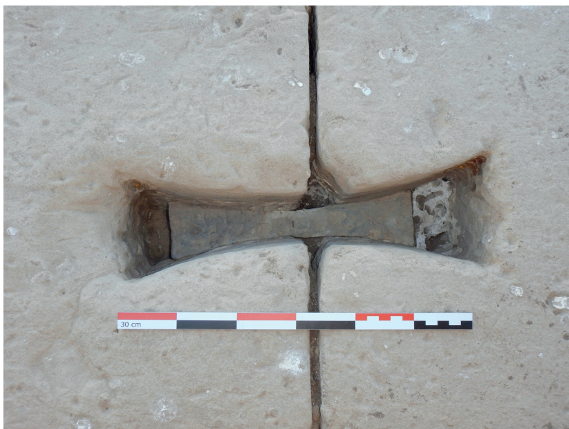
Fig. 8 Élévation ouest du mammisi romain, détail d'une agrafe en plomb (© Mission archéologique de Dendara, P. Zignani).
