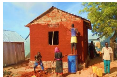
Earth plastering - © IOM
