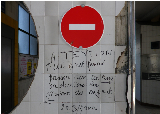
Panneau de signalisation et indications pour les déplacements piétons dans les galeries de l'Arlequin. Photographie Maïlys Toussaint, 19 mars 2016.
