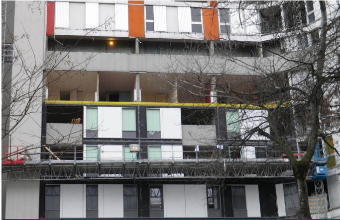
L'étape délicate du remplacement des façades au 40 Arlequin. Les anciennes façades (orange et blanc) en haut, et les nouvelles façades (gris et blanc) en bas. L'appartement ouvert au milieu est ici vide de locataires. Dans les logements habités, des panneaux provisoires sont installées en retrait à l'intérieur des logements. Photographie Maïlys Toussaint, 28 janvier 2016.
