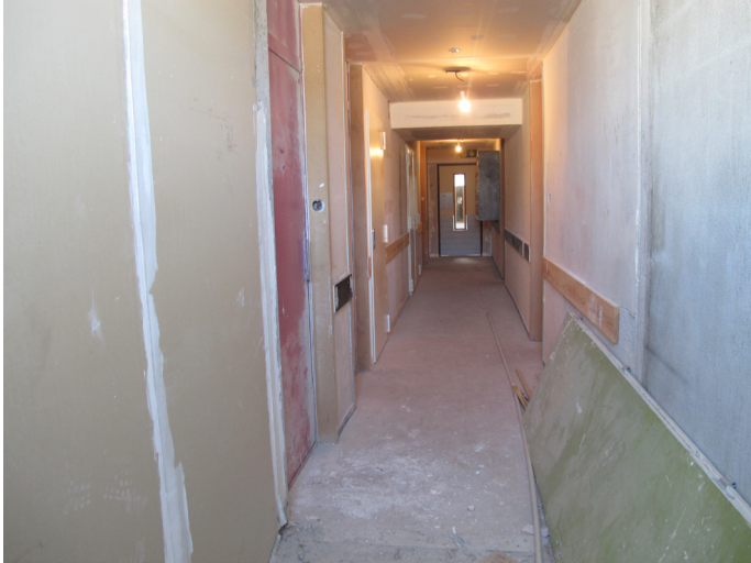
Les couloirs desservant les appartements du 40 Arlequin, pendant les travaux. Photographie Maïlys Toussaint, 22 octobre 2016.
