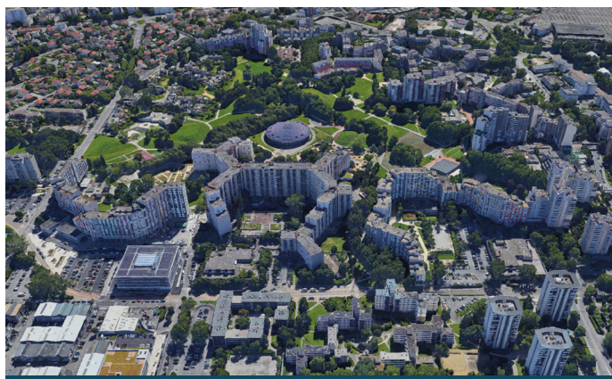
L'Arlequin serpente du nord (à gauche de l'image) au sud (droite). Au second plan apparaît le parc, au cœur du quartier de la Villeneuve de Grenoble. Données cartographiques : Google 2016
