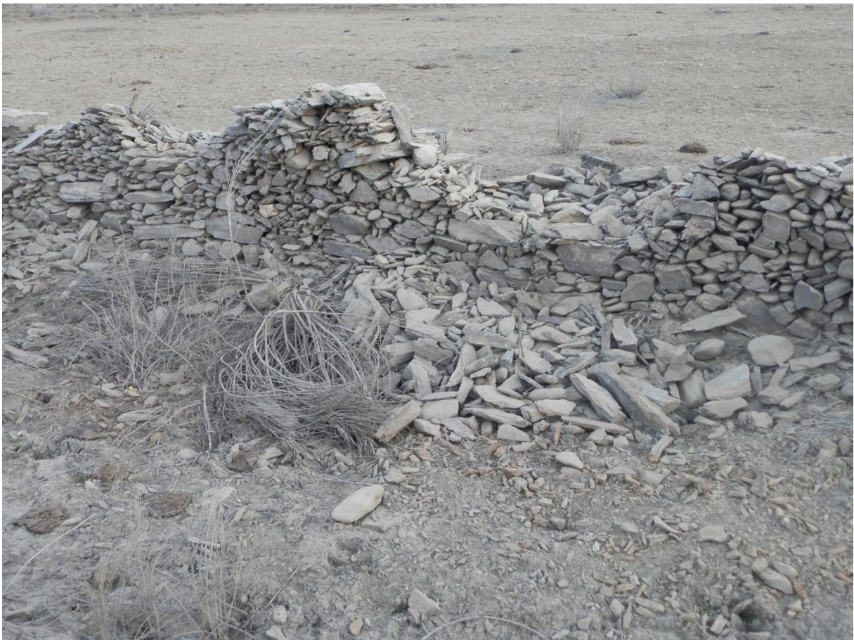
Fotografía 7: Muro bajo abandonado en el lugar de la nueva presa
