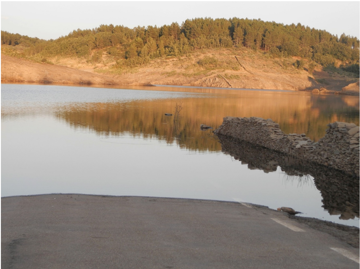
Fotografía 4: Carretera inundada interceptada por la nueva presa
