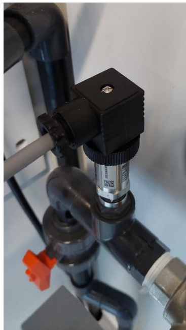
Image c : micro rupteur de pression
