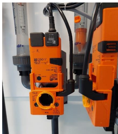
Image a : Vanne 3 voies à servomoteur
