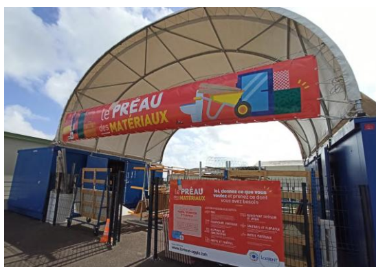
Photo 1 : Halle couverte du préau des matériaux, Caudan
