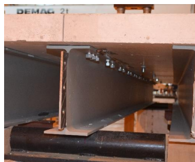
Photo 4 : Plancher mixte acier-béton
