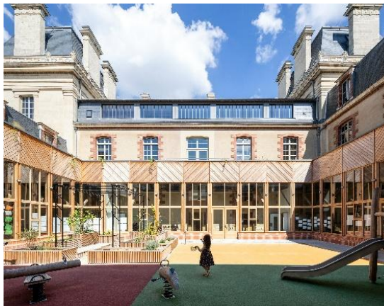
Photo 2 : Réhabilitation de l'Hôtel Pasteur, Rennes 2021
