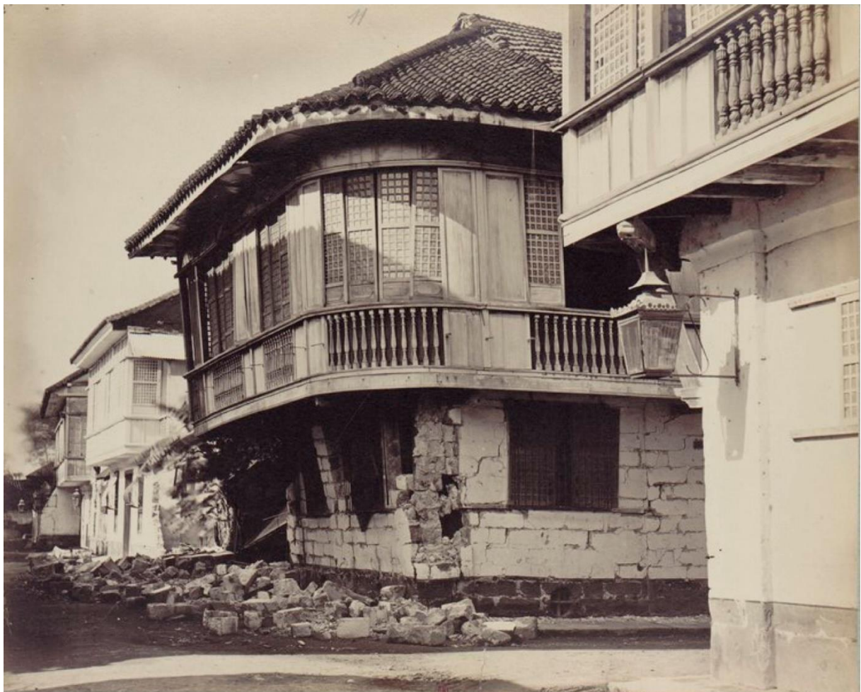
Fig.3 - Une maison de maçonnerie à l'angle de la rue Centeno, dans le quartier de Santa Cruz. La photographie a été prise peu de temps après les séismes des 18 et 20 juillet 1880. Les murs de maçonnerie du rez-de-chaussée se sont effondrés, mais l'étage et la toiture supportés par les poteaux de fond ont résisté aux secousses.
