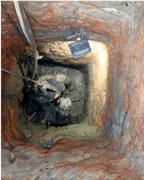
Le démontage de la plateforme marque la fin de l'intervention. La présence de la cavité nécessite des mesures de sécurité spécifiques, soit par l'obturation de la tête du conduit à l'aide de madriers, soit en conservant le harnachement et les dispositifs antichute.
