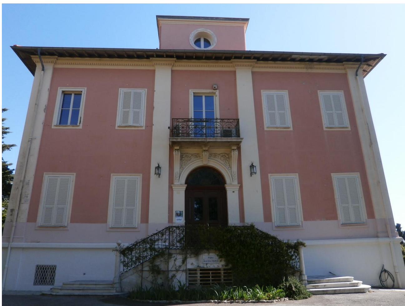
Villa Les Passiflores, façade principale sur jardin, orientée à l'ouest
