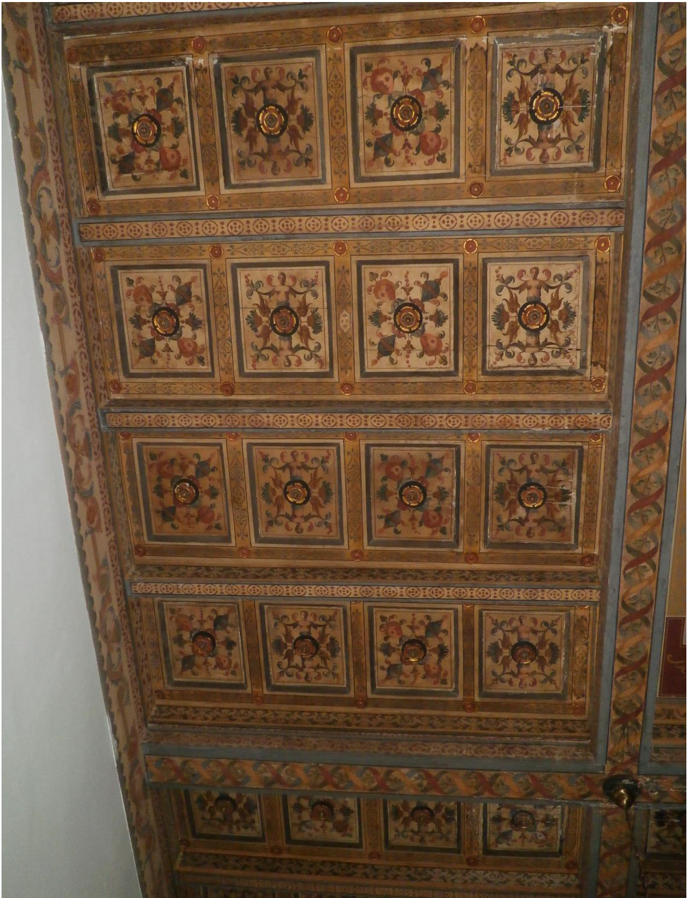
Plafond de la salle 12 (« Salon aux Entrelacs ») : détails des caissons polychromes ponctués de rosaces
