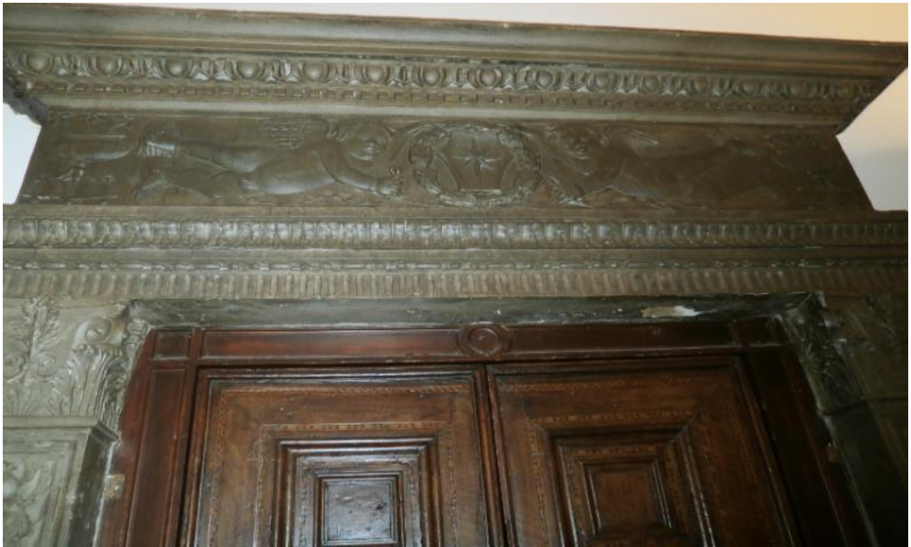
Lintheau de la porte de la Salle 12 ( « Salon aux entrelacs »). orné d'une rose des vents en blason dans une couronne de lauriers portée par des angelots (« putti »), pilastres latéraux avec pampres, pommes de pins et chapiteaux corinthiens
