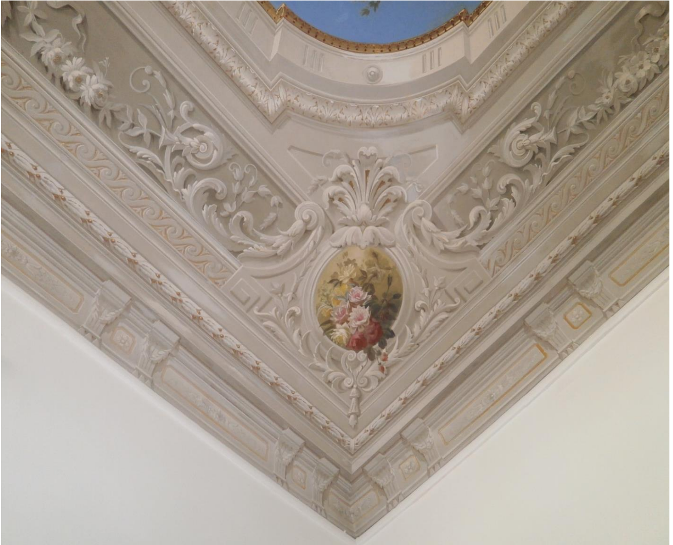
Plafond du Salon de réception : détail de la peinture ornementale en trompe l'œil
