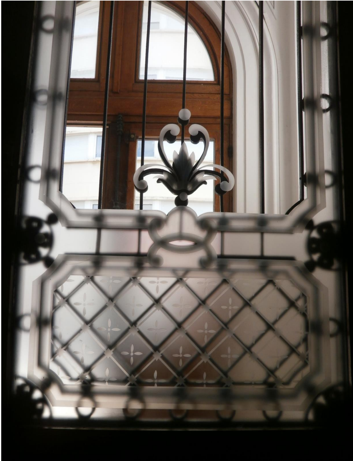
Vue intérieure de la seconde porte d'entrée de la Villa Montebello, vitre sérigraphiée
