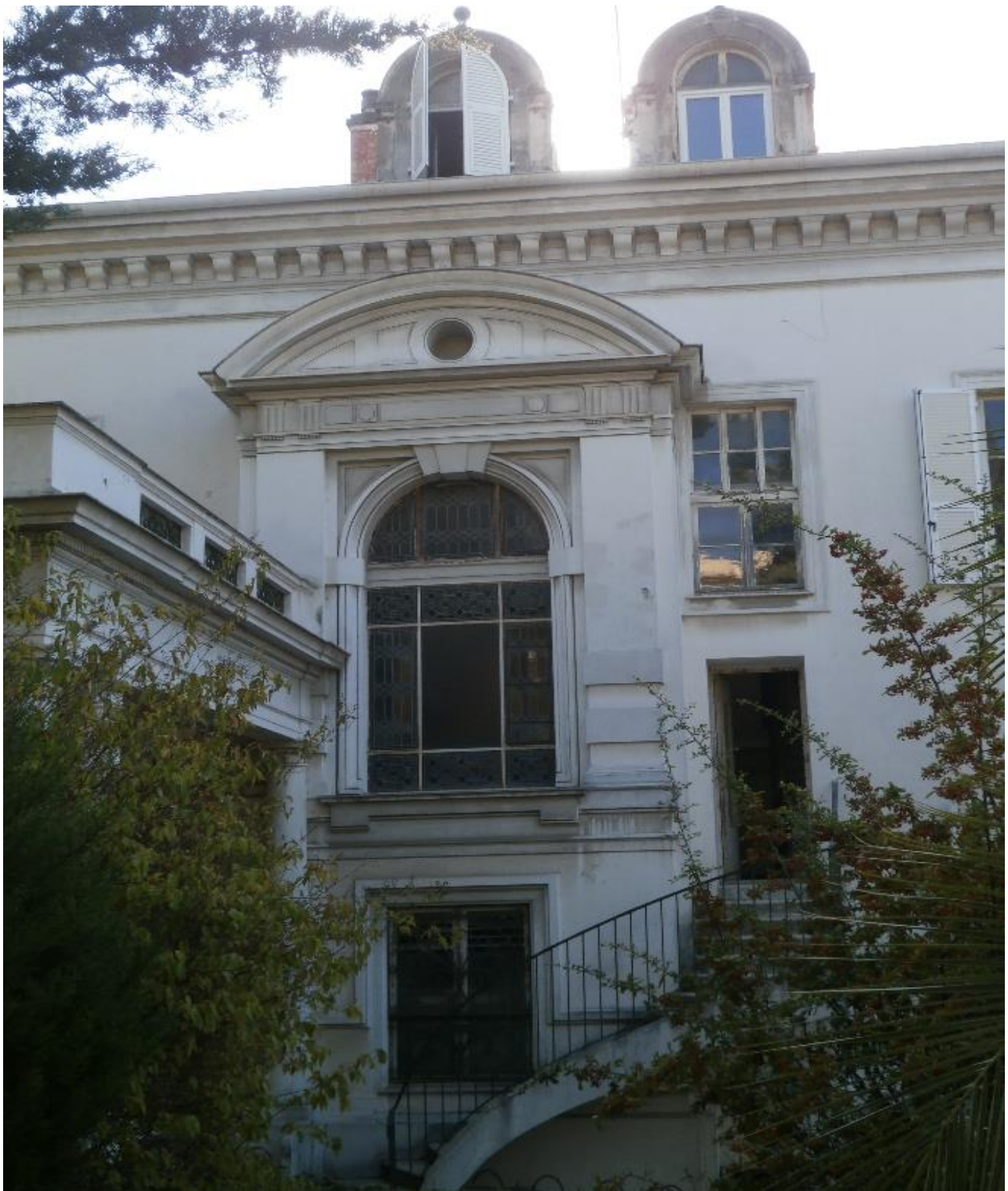
Vue arrière de la Villa Montebello avec péristyle à gauche pour abriter les voitures et grande baie vitrée donnant sur la cage d'escalier intérieur. Actuellement, un escalier de secours dessert les parties autrefois réservées aux pièces de service
