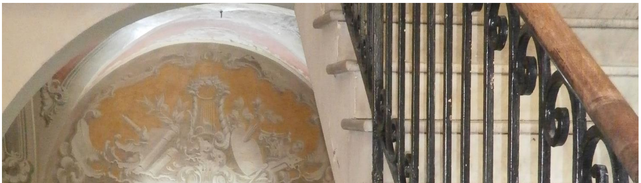
Détail de la montée d'escalier vers le premier étage de la Villa.
