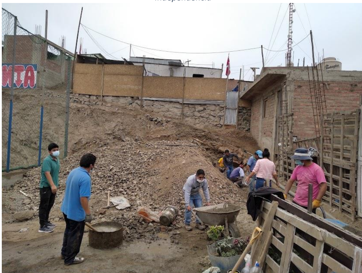
Fotografía 1: Realización de faena comunal para construcción de escaleras. Subzona Independencia
