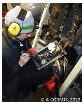
Figure 13. Refixage d'un combiné téléphonique, © A-CORROS, 2022.
