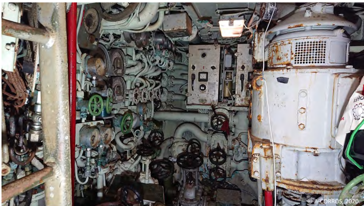
Figure 5. Vue du « plancher bas » de la tranche Centraux (TCB2), © A-CORROS 2020.
