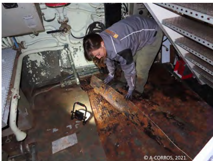
Figure 15. Étude des planchers et revêtements en cours, en tranche Torpilles, ©A-CORROS 2021.
