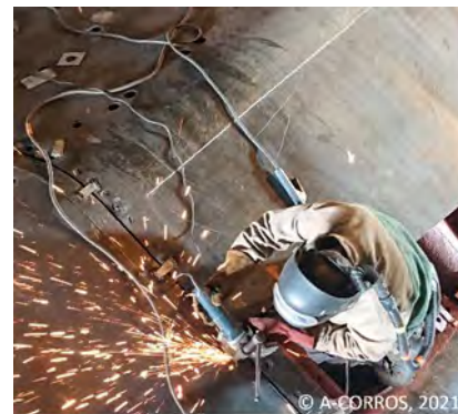
Figure 11. Carénage en cours, © A-CORROS 2021.
