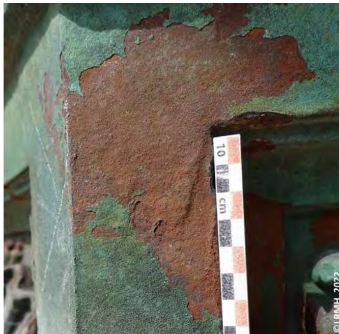
Figure 1. A gauche, cuivrage de la fontaine de la Grille du Coq, dans les jardins des Champs-Élysées ©LRMH 2022.
