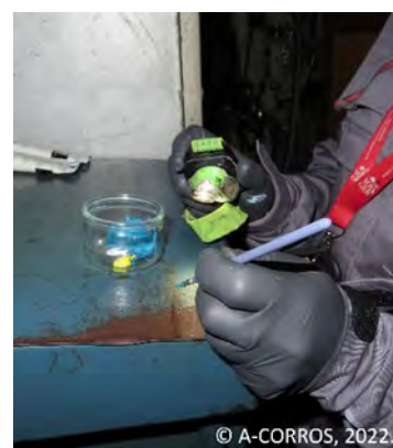
Figure 14. Retouche d'un élément visible, © A-CORROS, 2022.
