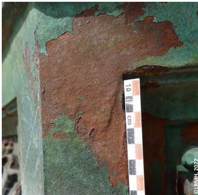
Figure 1. A gauche, cuivrage de la fontaine de la Grille du Coq, dans les jardins des Champs-Élysées ©LRMH 2022.
