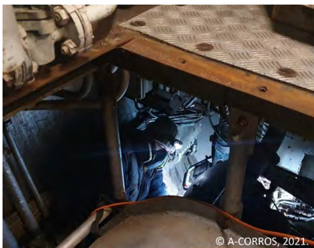
Figure 17. Intervention en plancher bas, à travers une trappe, ©A-CORROS 2021.
