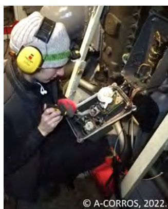
Figure 13. Refixage d'un combiné téléphonique, © A-CORROS, 2022.
