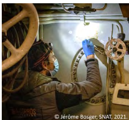
Figure 12. Retrait d'adhésif laissé par un élément de signalétique, © Jérôme Bosger, SNAT, 2021.
