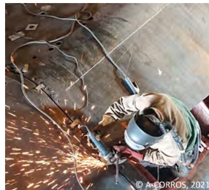
Figure 11. Carénage en cours, © A-CORROS 2021.
