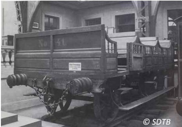
Figure 8. Tout à droite, on aperçoit les filets blancs sur le longeron du châssis. © SDTB
