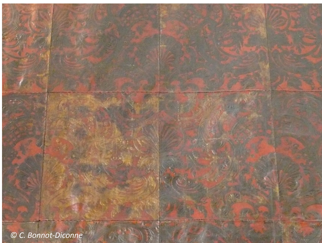
Figure 4. Noircissement des feuilles d'argent. Salle Toro, Hôtel de Ville d'Aix-en-Provence. Décor en cuir doré repoussé à fond rouge. Atelier Boissier, 1738. © C. Bonnot-Diconne 2009.
