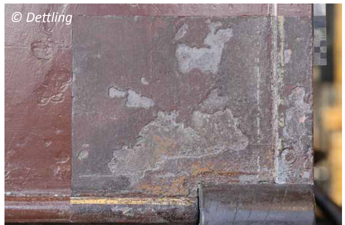
Figure 22. Surface après intégration des lacunes.
