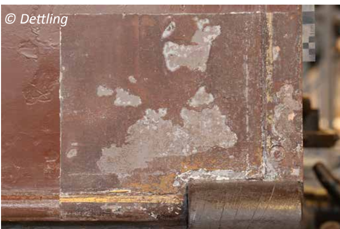
Figure 21. Surface révélée après sablage.
