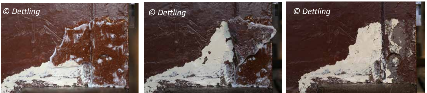
Figure 16. Essai du gel PVAc: a. Application ; b. Enlèvement ; c. Résultat. © Dettling
