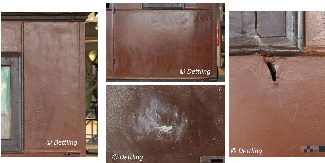
Figure 2. Aspects de surfaces hétérogènes : zone inférieure droite : a. Côté D ; b. Zone supérieure droite, côté D ; c. Masticage, zone inférieure, côté B ; d. Paroi endommagée, côté D. © Dettling
