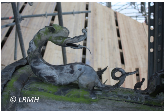
Figure 8. Sculptures de salamandre ornant la base de l'épi E1 ; la salamandre située à gauche est beaucoup plus ouvragée que celle de droite. Elle présente en outre de nombreuses brasures de réparation. La salamandre de droite remplace vraisemblablement une salamandre originale qui était manquante ou trop altérée. © LRMH
