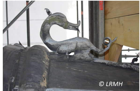
Figure 8. Sculptures de salamandre ornant la base de l'épi E1 ; la salamandre située à gauche est beaucoup plus ouvragée que celle de droite. Elle présente en outre de nombreuses brasures de réparation. La salamandre de droite remplace vraisemblablement une salamandre originale qui était manquante ou trop altérée. © LRMH
