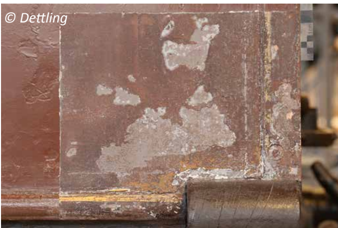
Figure 21. Surface révélée après sablage.
