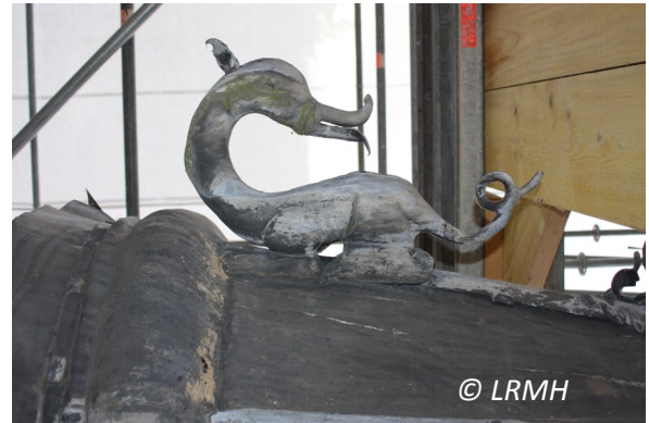
Figure 7. Épi de faitage E8 du château d'Azay-le-Rideau. Les différents modules sont assemblés les uns aux autres par brasage. Certains éléments se sont affaissés. © LRMH
