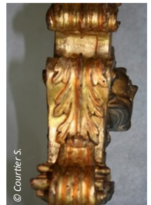
Figure 36. Remise à jour du vermillon. ©Courtier S.
