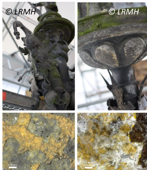
Figure 11. Restes de dorure à la feuille sur les épis de faitage E2 (sur le coin de l'œil gauche du personnage) et E1 du château d'Azay-le-Rideau (au centre des godrons) ; la teinte dure employée pour la dorure de l'épi E1 contient du jaune de chrome, ce qui suggère une mise en œuvre au XIX e siècle. L'or des pièces de l'épi E1 est mis en valeur par l'application de rehauts noirs (bordure des godrons). © LRMH
