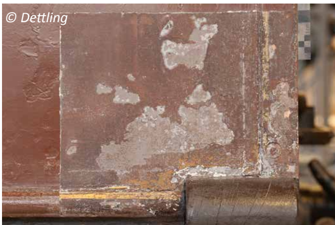
Figure 21. Surface révélée après sablage.
