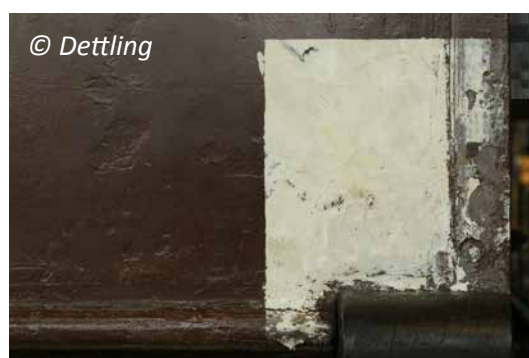
Figure 17. La surface après dégagement de la peinture brun-rougeâtre. © Dettling
