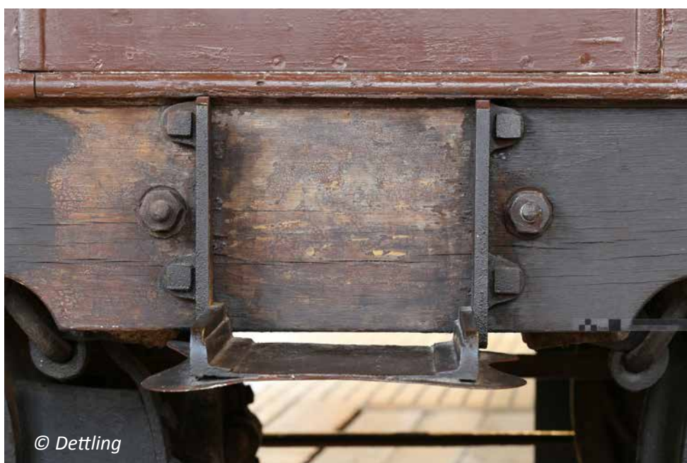
Figure 4. Partie non repeinte derrière la marche d'entrée rabattue, côté D. © Dettling
