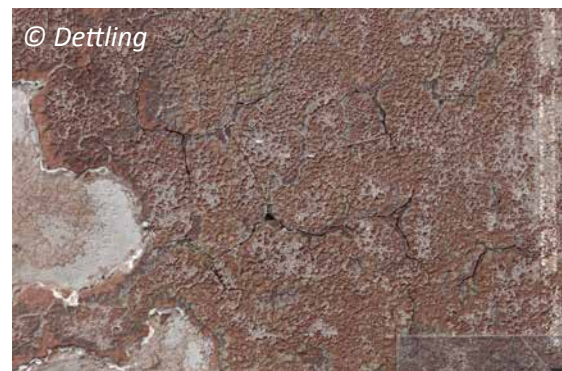
Figure 19. Détail de la surface révélée, peinture craquelée. © Dettling
