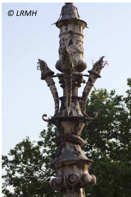
Figure 7. Épi de faitage E8 du château d'Azay-le-Rideau. Les différents modules sont assemblés les uns aux autres par brasage. Certains éléments se sont affaissés. © LRMH
