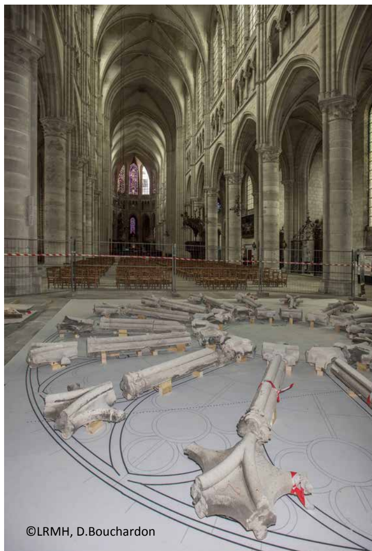
Figure 2. Remontage à plat de la rose de la cathédrale de Soissons (Aisne)
