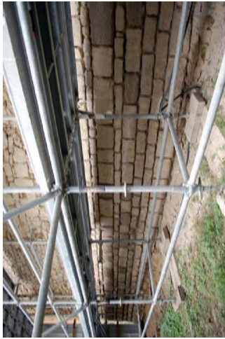
Mur de courtine orientale : appareil régulier de moellons en partie basse, au niveau du fruit
