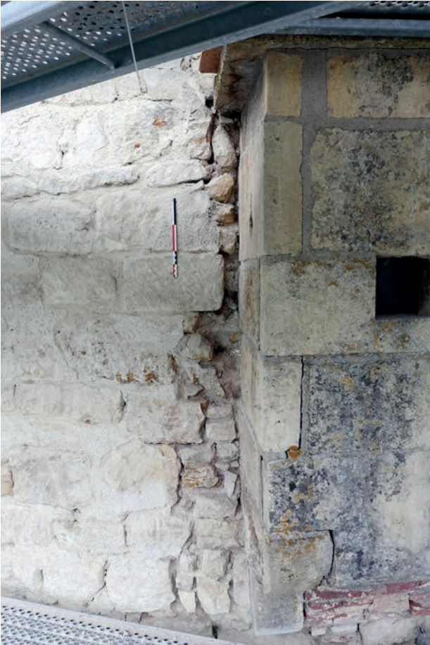
ill. 33 : Tour 8, césure d'insertion de la latrine inférieure dans la maçonnerie médiévale.
