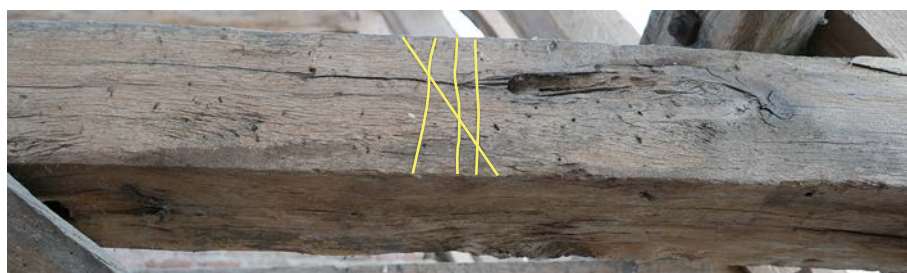
ill. 26 : Marque « VIII » avec langue de vipère et cercle - écharpe entre les F9' et F10' du versant EST.
