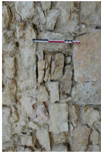
Parlement nord de la courtine, localisation des bouchages d'ancrage (trous de hourd ?)
