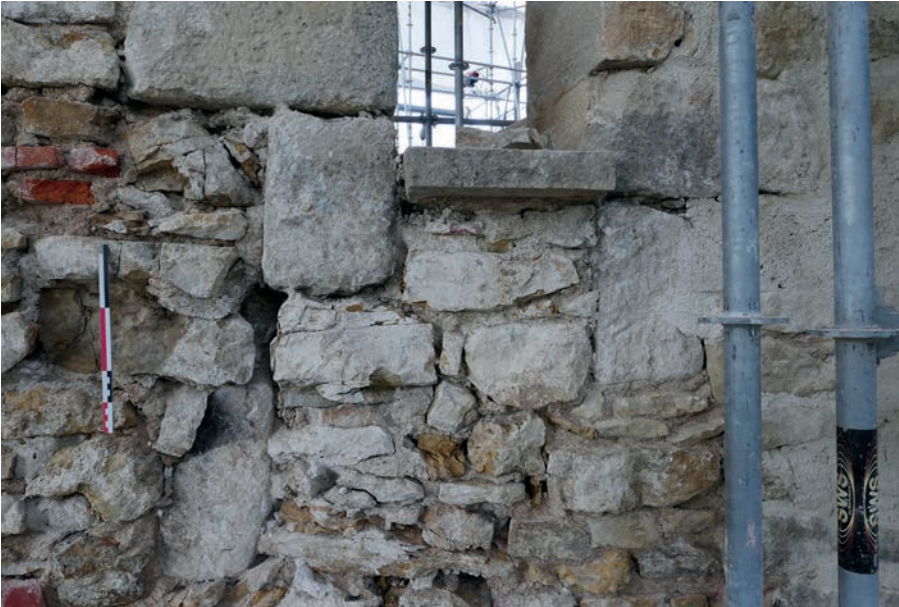
ill. 05 : Ancien piédroit d'un créneau, rehaussé et réduit en largeur (UM 13).
