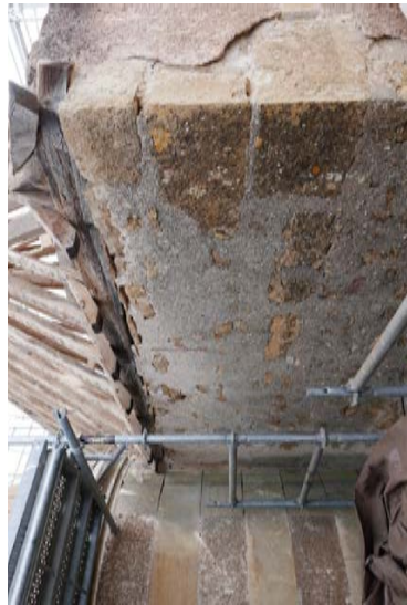
Parement qui ferme la tour : enduit couvrant postérieur à la tourelle sud-est
