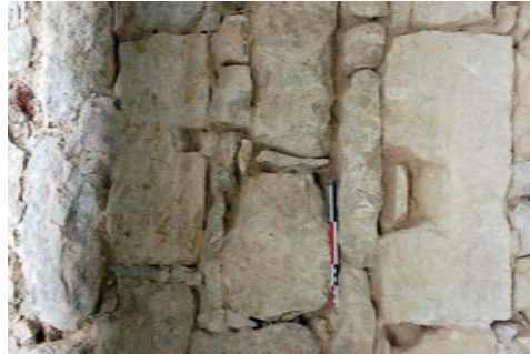
Mur de courtine orientale : pierres de taille en remploi, appui et linteau d'archère ?
