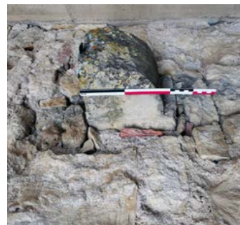
Mur sud du logis, corbeau le plus à l'est
