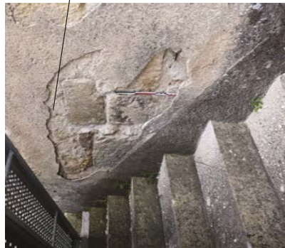
Courine SUD, à gauche avant piquage : piedroit sud d'une ouverture de tir murée ; à droite après dégrossi : linteau de l'ouverture 2
