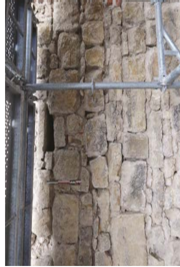
Parement OUEST de la courtine sud, trou partiellement débouché
