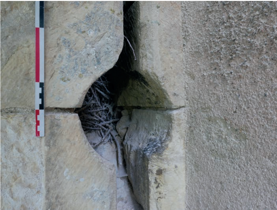
ill. 17 : Trou de visée repercé dans la fente d'une archère en rame de la tour 6, côté OUEST.
