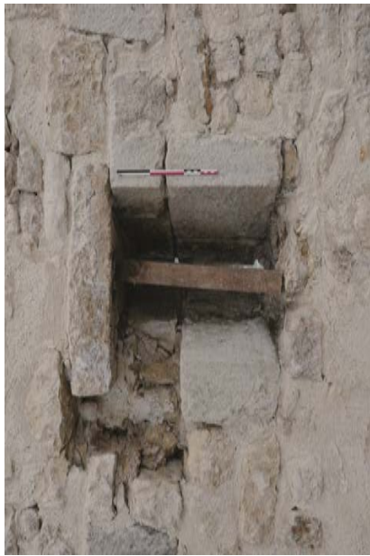
Courine sud, fente de tir dans le merlon central, linteau modifié
