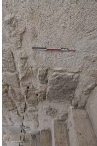
Courine SUD, à gauche avant piquage : piedroit sud d'une ouverture de tir murée ; à droite après dégrossi : linteau de l'ouverture 2
