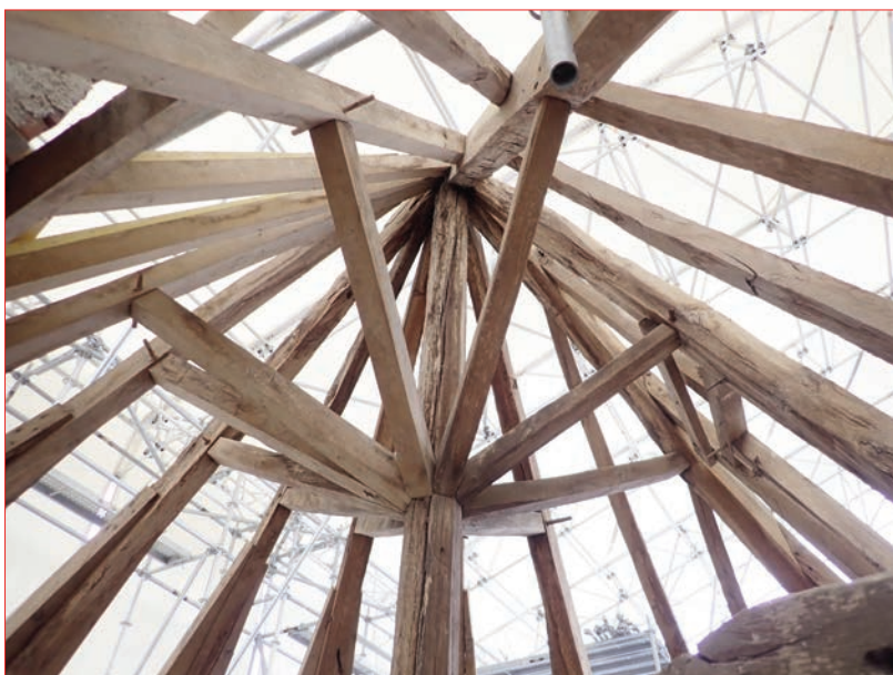
Photo 1 (en haut) : Vue de la charpente de la tour n° 6.
