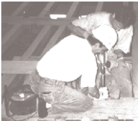
Photo 1 (Lavoyer) : Prélèvement à la tarière électrique
