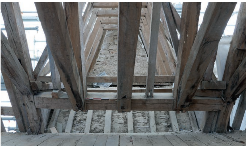
ill. 24 : Chevêtre de la lucarne SUD du bâtiment NORD.
