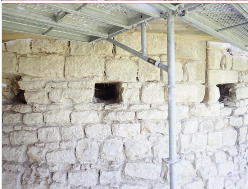
Photo 5 (en haut) : Élément de hourd déposé - Tour n° 6.
