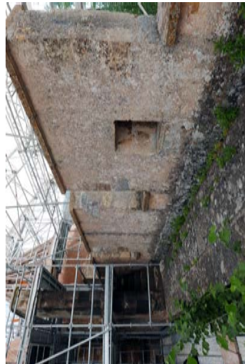
Crénelage de la courinne sud avec meurtrières dans un merlon et enduit couvrant
