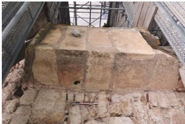
Tour 8. insertion d'une latrine à l'emplacement d'un créneau
