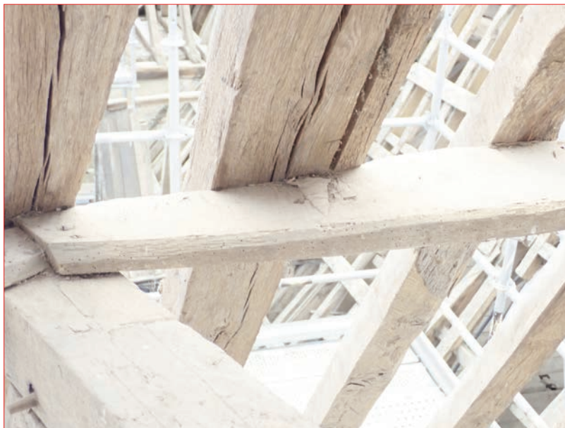
Photo 11 (en haut) : Chevron avec un embrèvement simple en pied - tour n° 7.
