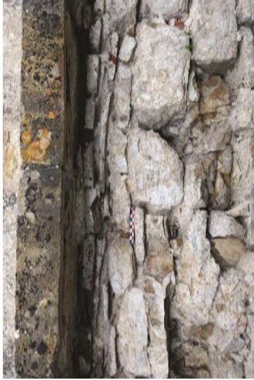
Sol du chemin de ronde de la courtine postérieur à l'époque médiévale : les dalles sont fixées à l'aide de petites briques et de fragments de tuiles
