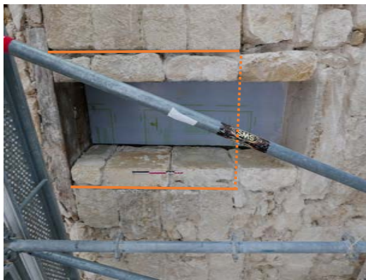
Tour 6, créneau transformé en fenêtre
