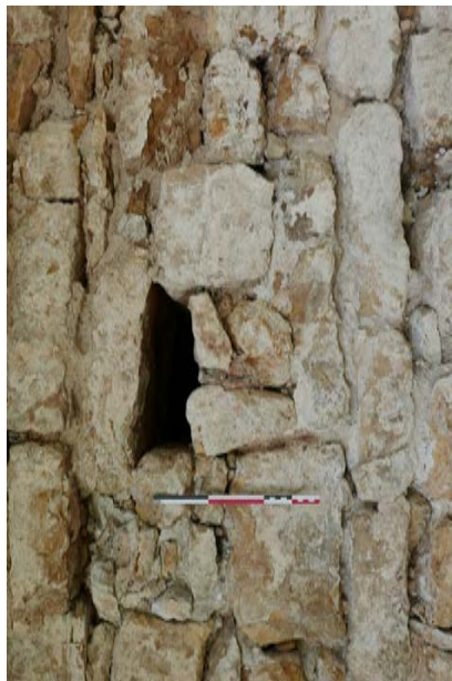
Parement oriental de la courtine, trou de hourd en partie débouché
