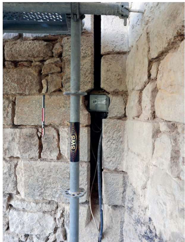
ill. 11 : Archère en rame de la tour 7, niveau inférieur côté OUEST, trou de visée repercé.
