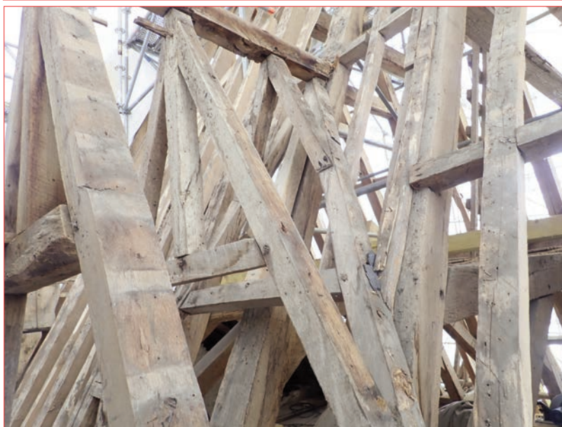
Photo 1 (en haut) : Vue de la charpente découverte de la lucarne ouest sur cour. Photo 2 (en bas) : Ferme inclinée contre la charpente du logis (à droite) - lucarne ouest sur cour.
