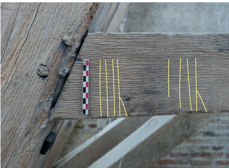
ill. 29 : Marque double « IIII » avec une langue vipère sur l'aisselier du versant SUD de la ferme F4 du corps de bâtiment NORD.
