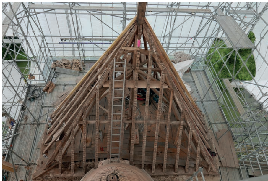
ill. 35 : Vue générale de la charpente de la tour 8.
