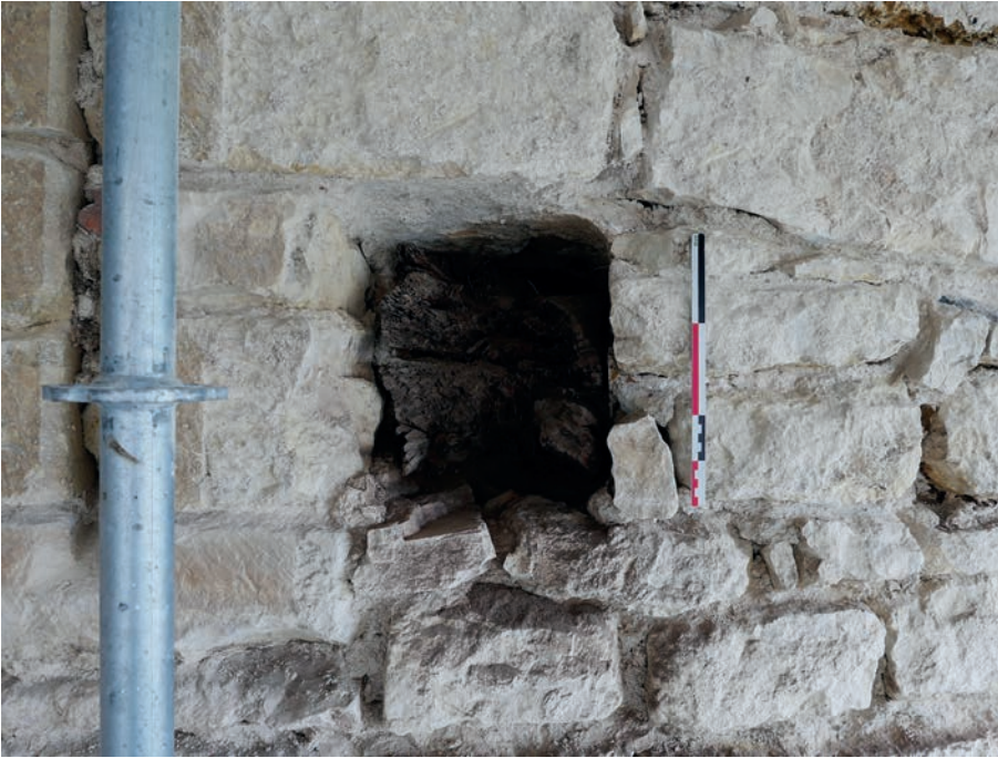
ill. 13 : Tour 6, trou de hourd avec bois scellé à l'intérieur.
