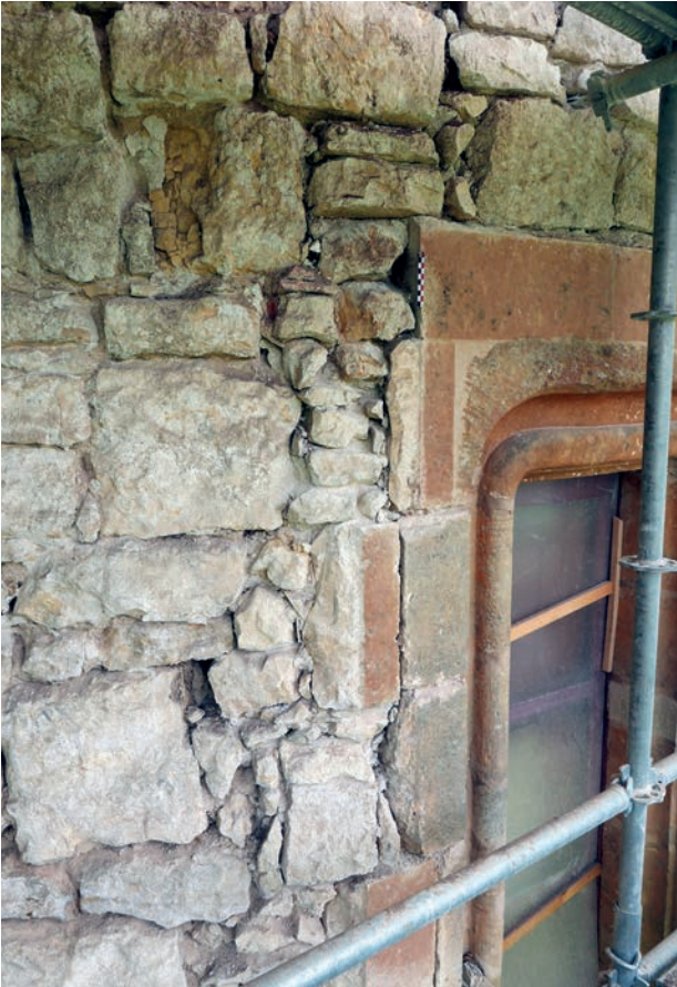
ill. 38 : Tour 6, reprise de l'encadrement de la fenêtre à l'aide de pierres taillées jaune-orange.
