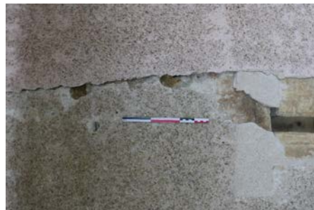
Tour 6, détail de la césure entre l'enduit brun-gris (à gauche) et l'enduit rose (à droite).
