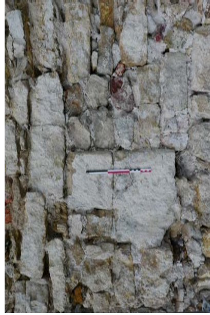
Parement oriental de la courtine : fente de tir la plus au nord, démontée puis murée
