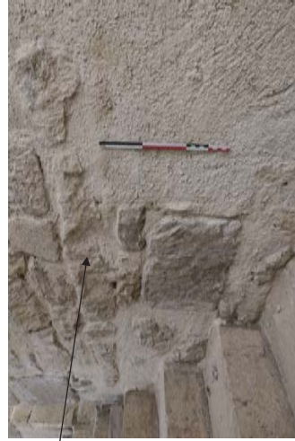
Courtine SUD, à gauche avant piquage : piedroit sud d'une ouverture de tir murée ; à droite après dégrossi : linteau de l'ouverture ?
