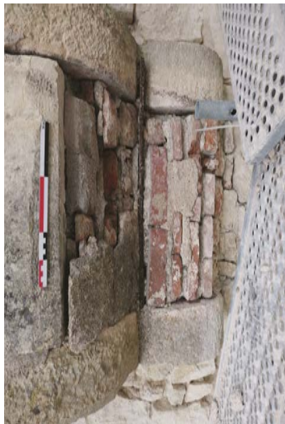
Latrines inférieures de la tour 8, bouchage de l'orifice
