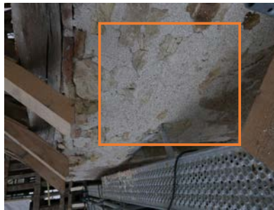
Partie supérieure de la tour 6, localisation du sondage
