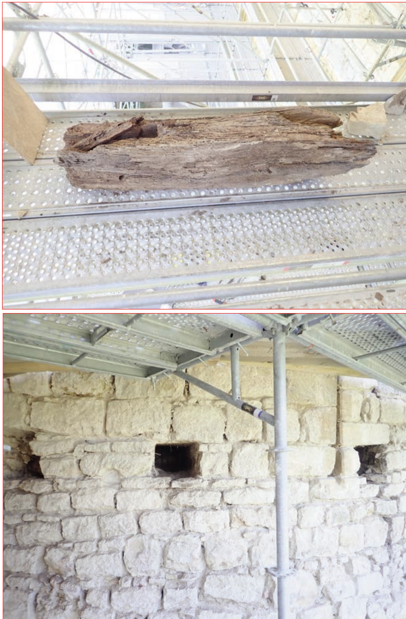
Photo 5 (en haut) : Élément de hourd déposé - Tour n° 6.
