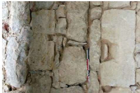
Mur de courtine orientale : pierres de taille en remploi, appui et linteau d'archère ?
