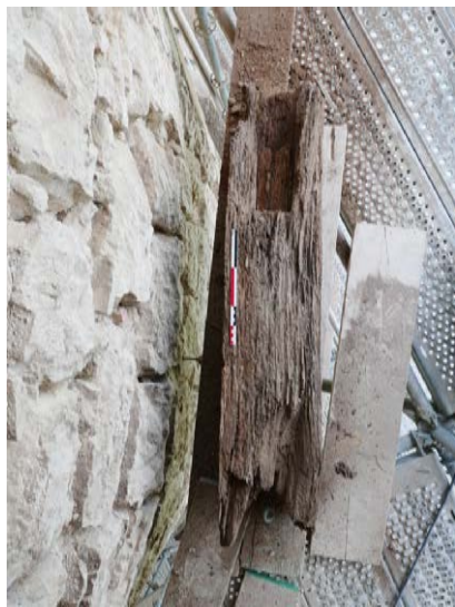
Pièce de bois déposée, provenant du hourd de la tour 6
