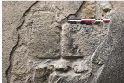
Crénelage de la courtoine sud : vestige d'une meurtrière ?
