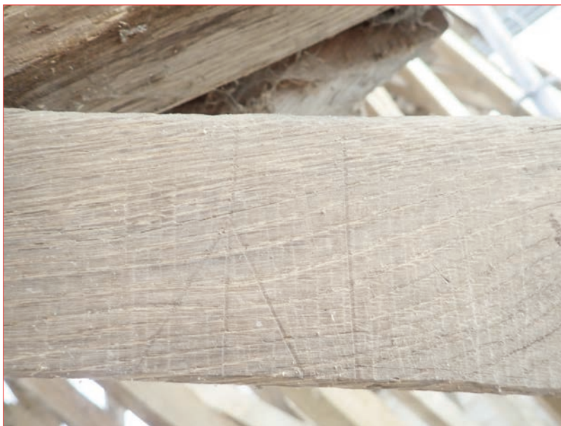
Photo 3 (en haut) : Triangle d'arrachement des fibres consécutif au sciage manuel d'un bois - Tour n° 6.
