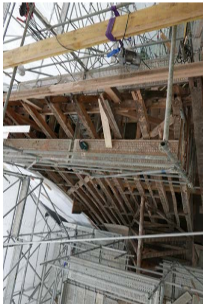
Vue générale de la charpente de l'aile orientale du logis
