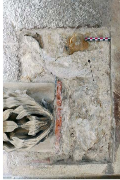
Façade ouest de l'aile orientale du logis, culot sculpté réinséré et joints beurrés d'origine
