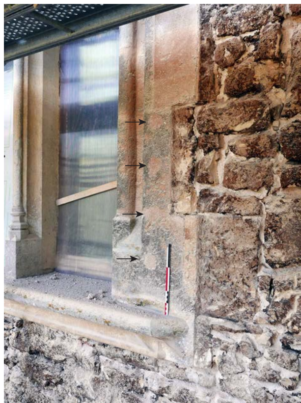
ill. 43 : Façade NORD du logis, trous bouchés dans la fenêtre du rez-de-chaussée la plus à l'OUEST.
