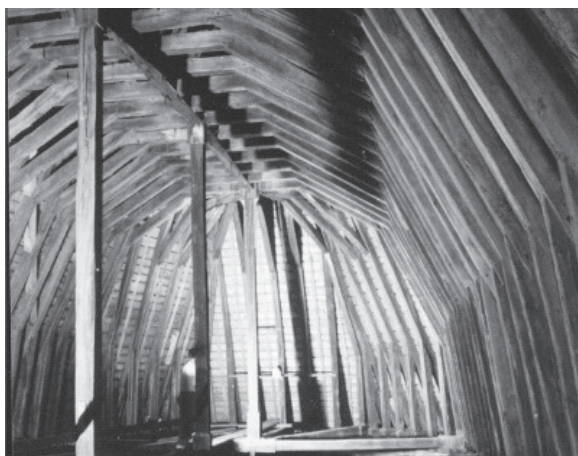
Photo 3 : vue de la charpente de la Sainte Chapelle de Riom (63)
