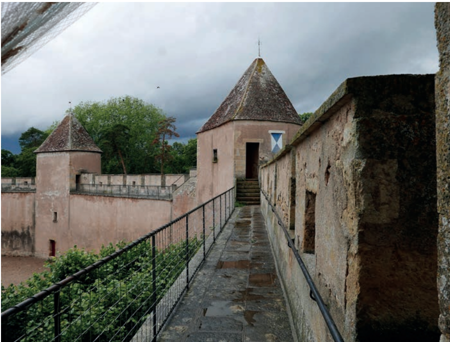
ill. 16 : Chemin de ronde au sommet de la courtine NORD-OUEST UM 12, vers la tour 5.
