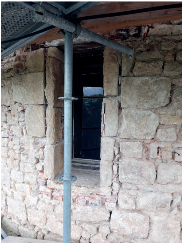
ill. 21 : Tour 6, rétrécissement de l'ouverture d'un créneau transformé en fenêtre.
