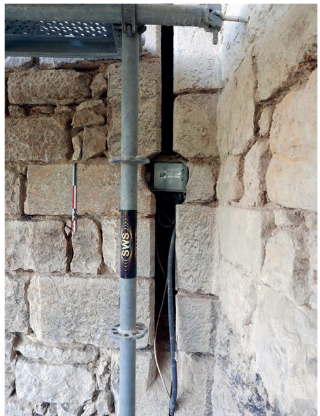
ill. 11 : Archère en rame de la tour 7, niveau inférieur côté OUEST, trou de visée repercé.
