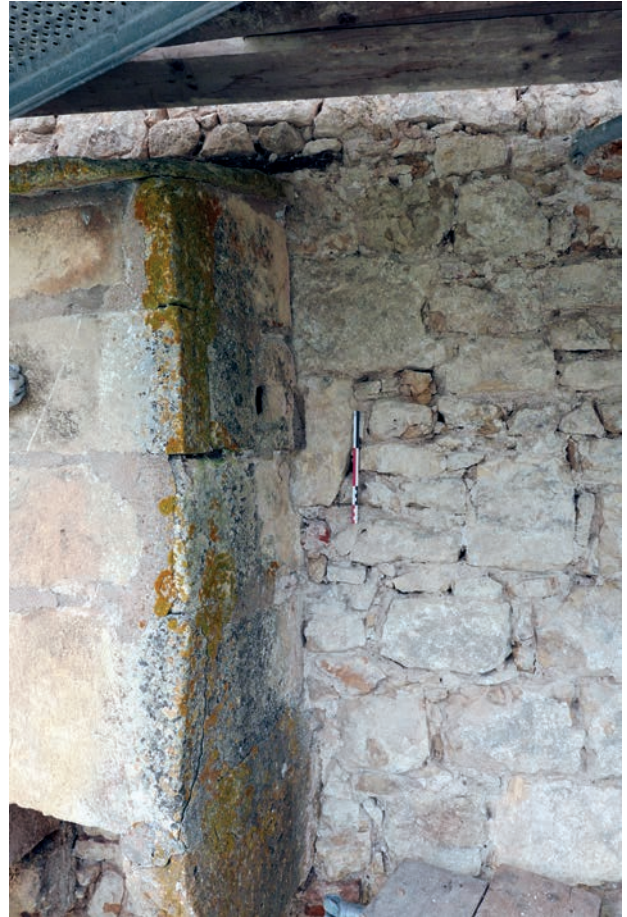
ill. 34 : Tour 8, insertion de la latrine supérieure dans un créneau.
