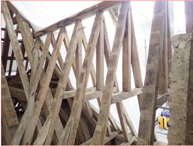
Photo 17 : Charpente de la lucarne en pierre - versant sud du logis nord.
