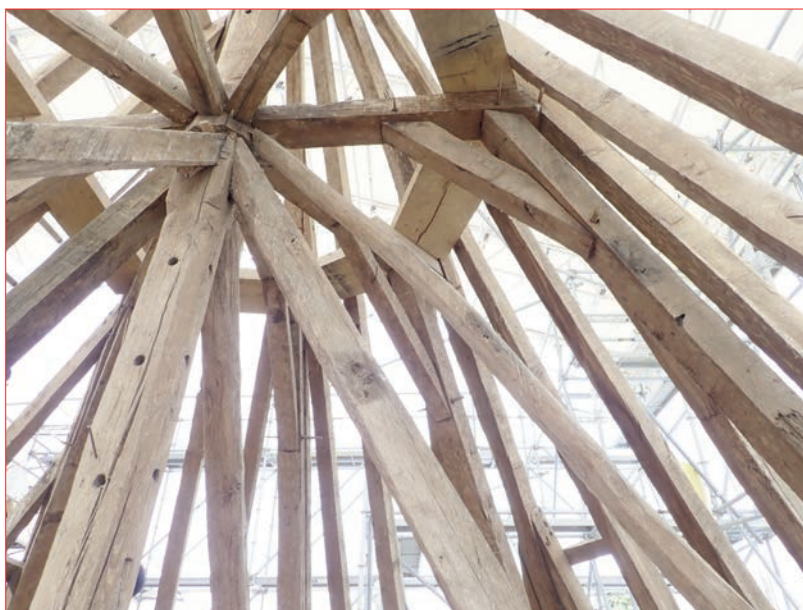
Photo 4 (en haut) : Vue de la charpente de la tour n° 8.
