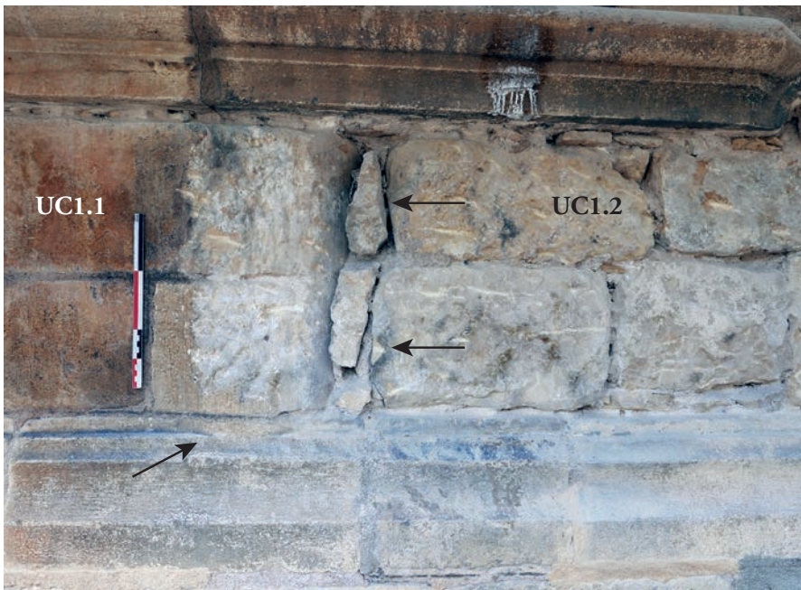
ill. 30 : Vestige du piédroit ouest de la fenêtre disparue dans l'UM 1.
