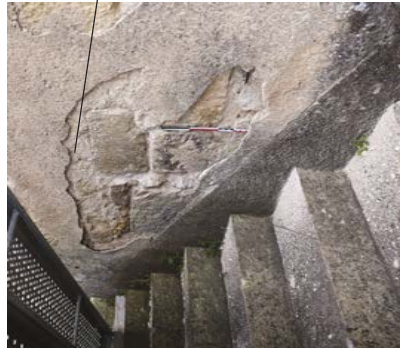
Courtine SUD, à gauche avant piquage : piedroit sud d'une ouverture de tir murée ; à droite après dégrossi : linteau de l'ouverture ?
