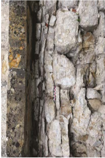
Sol du chemin de ronde de la courtine postérieur à l'Époque médiévale : les dalles sont fixées à l'aide de petites briques et de fragments de tuiles
