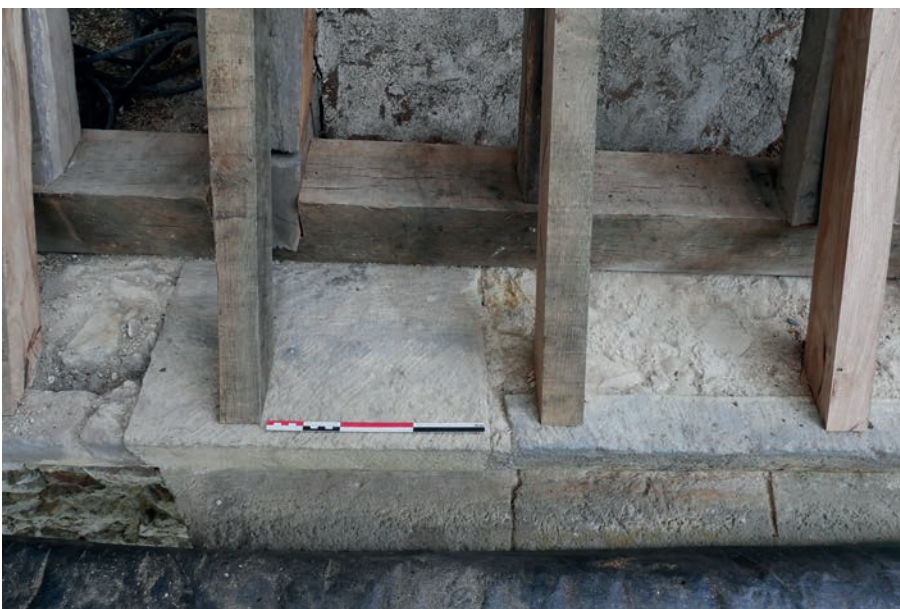
ill. 19 : Rez-de-chaussée du logis, l'appareil de l'escalier d'honneur (à droite) vient contre celui du bâtiment nord (à gauche).
