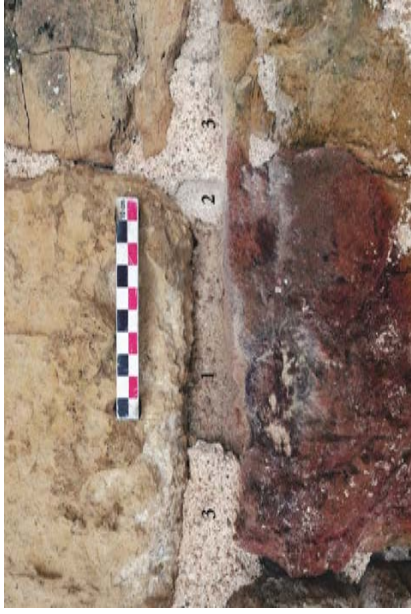
Courtine SUD, extrémité sud du parement ouest : 1 correspond au mortier de construction, 2 correspond à l'enduit de la porte du château appliqué en partie sur la courtine ; 3 correspond à l'enduit le plus récent de la courtine
