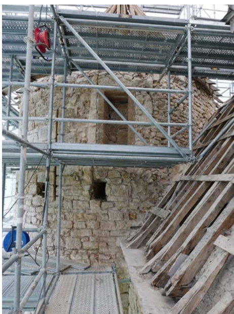
Figure 20 : Parties hautes de la tour 7, arrachement à l'aplomb de la courtine nord UM 5.
