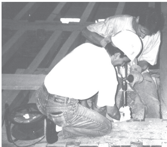
Photo 1 (Lavier) : Prélèvement à la tarière électrique
