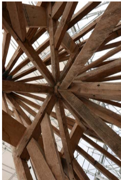
Tour 8, poinçon de la charpente
