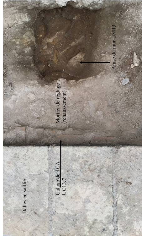
Courtine SUD, stratigraphie de mise en œuvre du chemin de ronde
