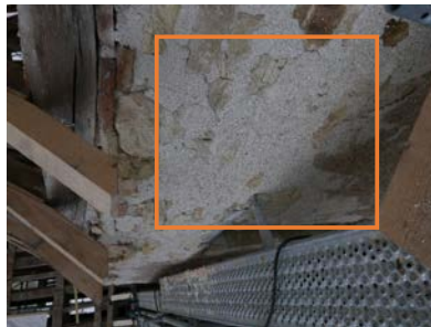
Partie supérieure de la tour 6, localisation du sondage
