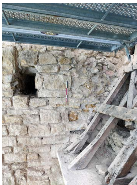
Figure 20 : Parties hautes de la tour 7, arrachement à l'aplomb de la courtine nord UM 5.
