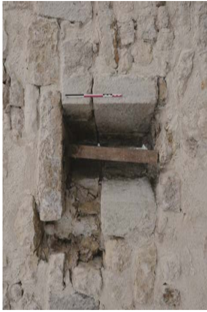
Courtine sud, fente de tir dans le merlon central, linteau modifié
