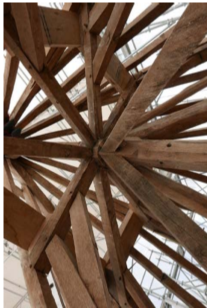
Tour 8, poinçon de la charpente
