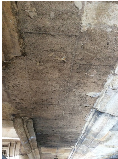
Logis, mur sud : enduit ancien avec incisions
