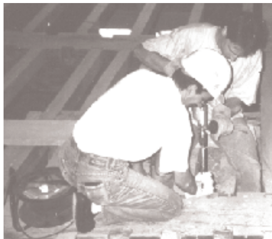
Photo 1 (Lavoyer) : Prélèvement à la tarière électrique
