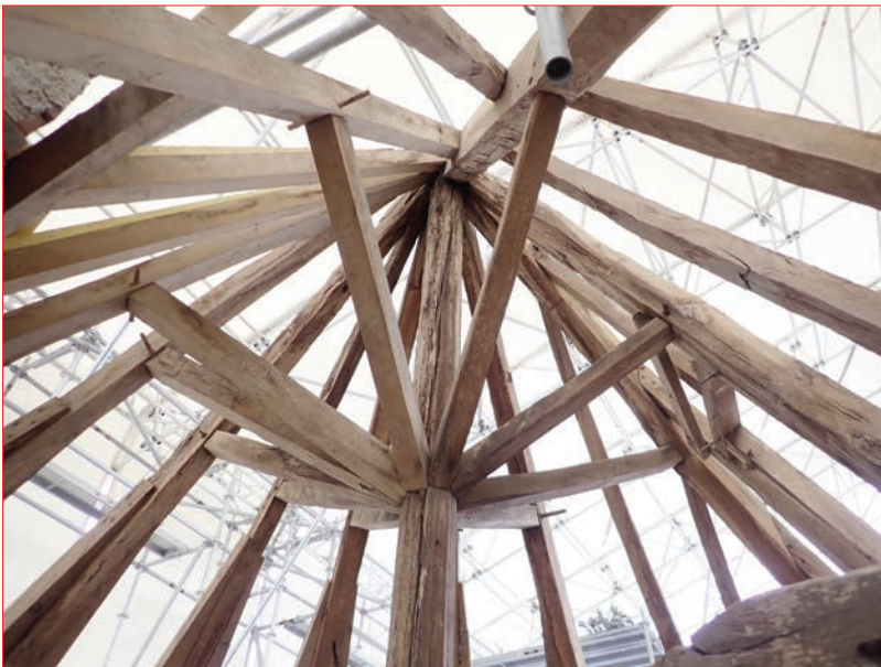
Photo 1 (en haut) : Vue de la charpente de la tour n° 6. Photo 2 (en bas) : Partie supérieure de la charpente constituée de contrefiches assemblées au poinçon central - tour n° 6.
