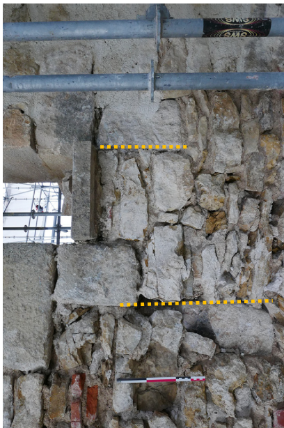
Parement oriental de la courtine, reprise du créneau le plus au nord
