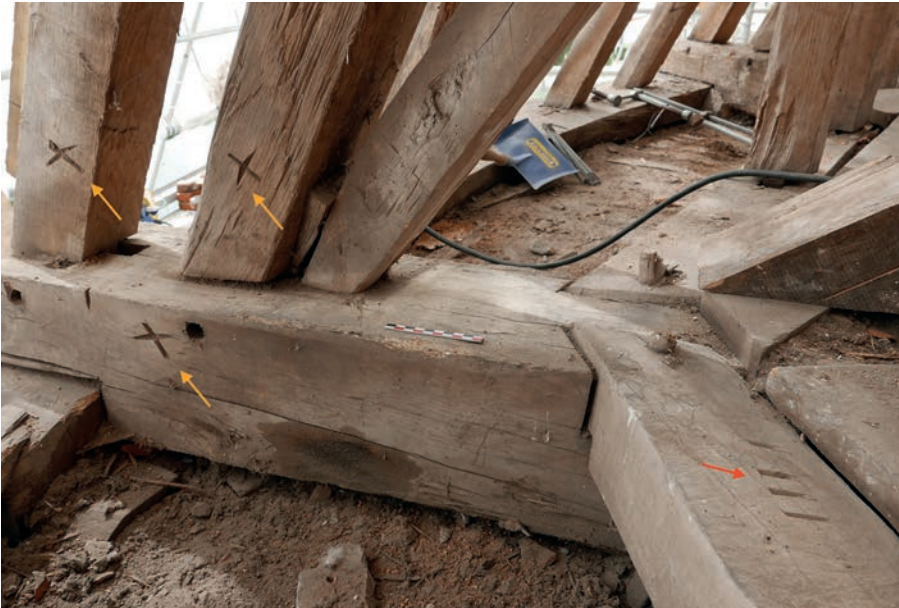
ill. 36 : Marquage du pied de la ferme principale par un « X » et marquage « IIII » du gousset.
