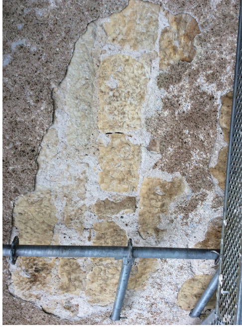
Tour 7, détail de la maçonnerie d'origine
