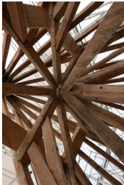
Tour 8, poinçon de la charpente
