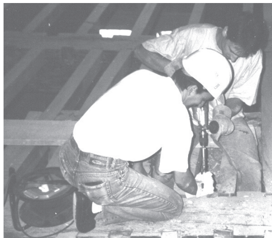
Photo 1 (Lavoyer) : Prélèvement à la tarière électrique
