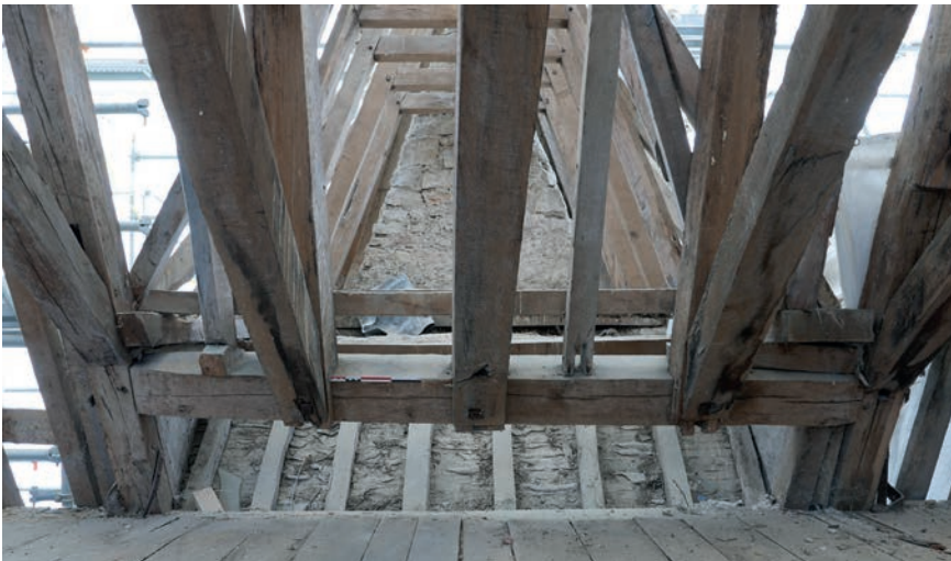
ill. 24 : Chevêtre de la lucarne SUD du bâtiment NORD.
