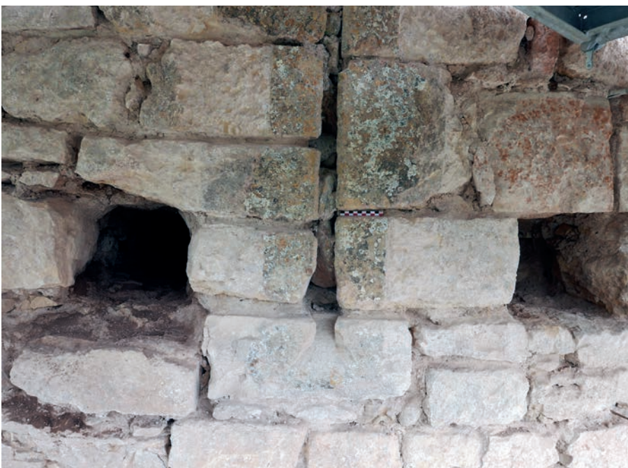
ill. 09 : Partie basse d'une archère, fente chanfreinée et étrier triangulaire (tour 6).
