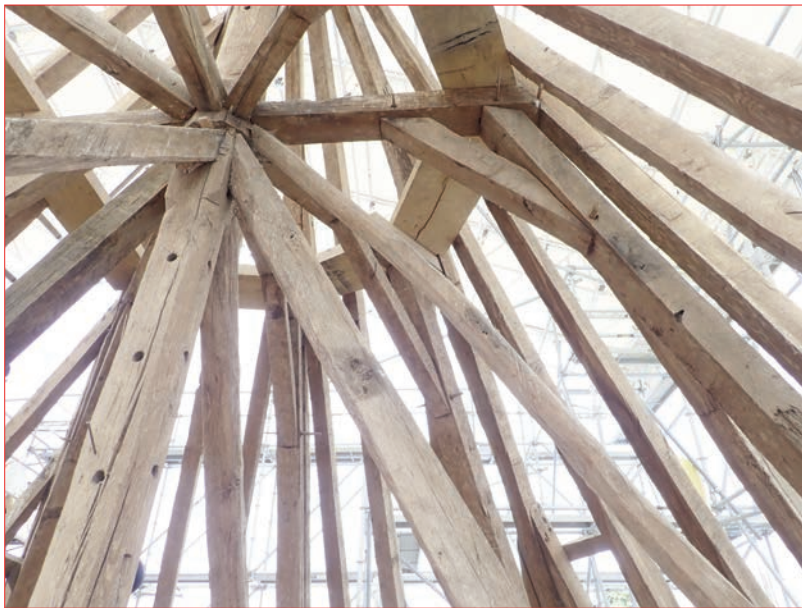
Photo 4 (en haut) : Vue de la charpente de la tour n° 8.
