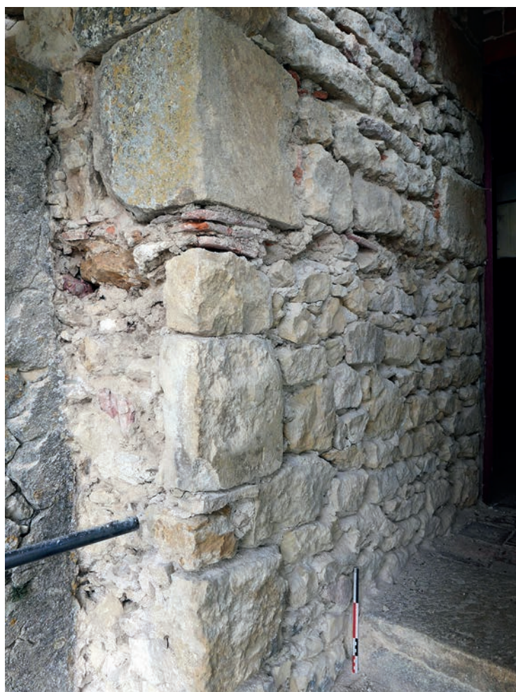
Figure 25 : Linteau réinséré dans la maçonnerie de la tour 6 (UC 4.7).
