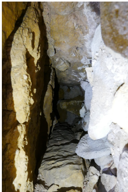
Parement oriental de la courtine, intérieur d'un trou de hourd
