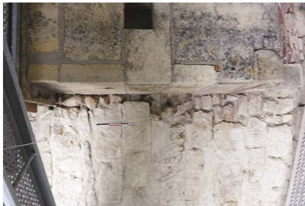
Latrines inférieure de la tour 8, césure d'insertion du côté sud
