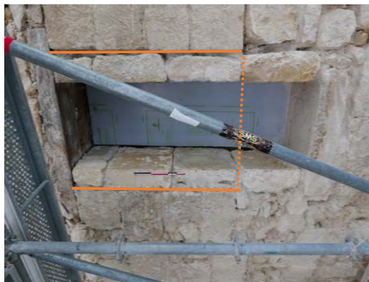
Tour 6, créneau transformé en fenêtre
