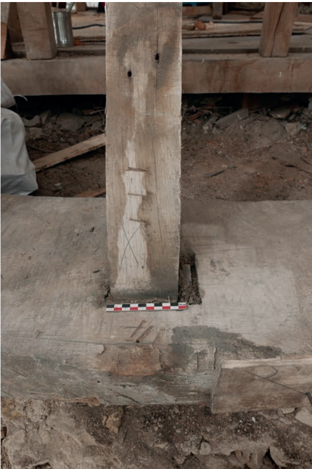
ill. 36 : Marquage du pied de la ferme principale par un « X » et marquage « IIII » du gousset.
