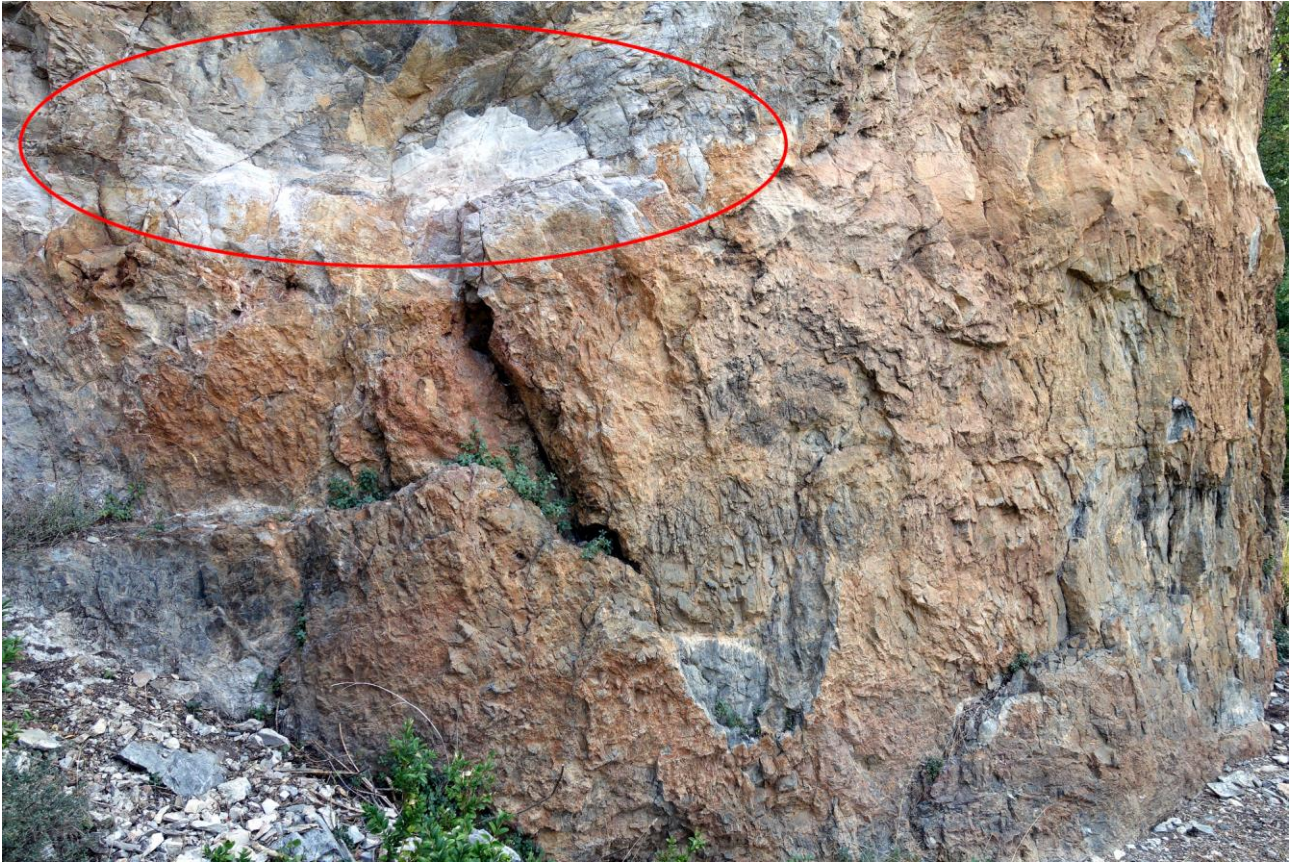
Fig. 8 : Une des marches taillées en partie basse de la paroi
