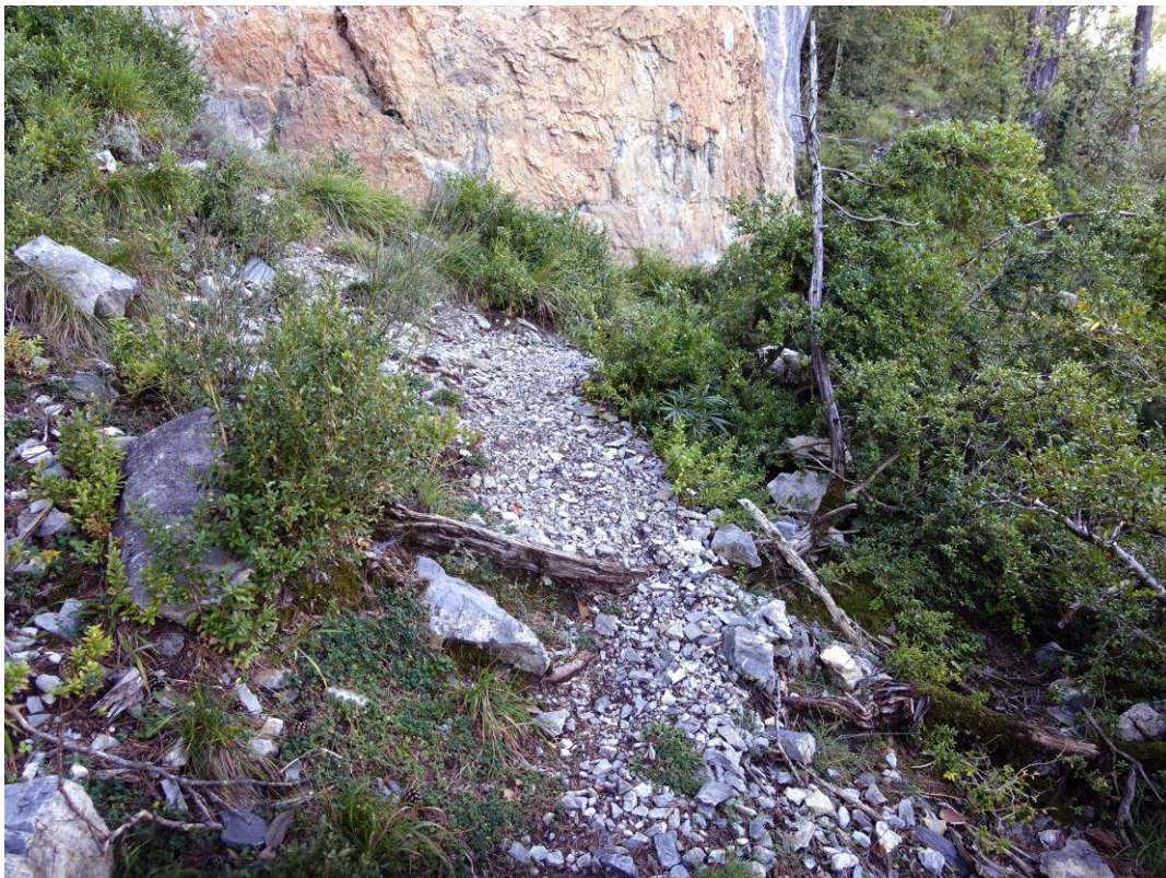
Fig. 25 : Débouché du sentier et zone écroûtée en aval
