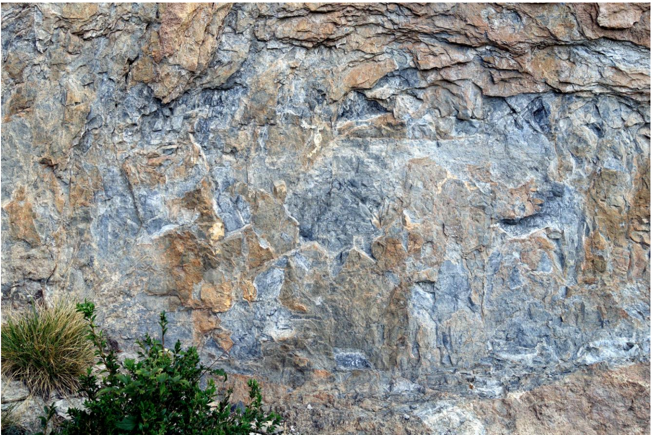
Fig. 7 : Zone éroûtée en amont (détail : vestiges de peintures)
