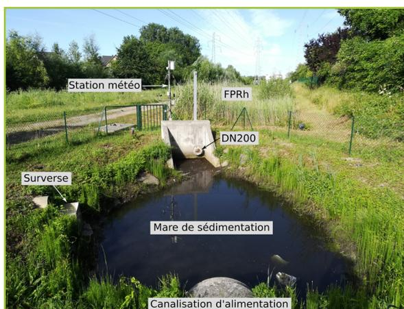
**Figure 2 : Focus sur la ZHA n°2 avec 1-La canalisation d'arrivée des eaux pluviales strictes. 2- La mare de sédimentation. 3- Le trop-plein. 4-La canalisation vers le filtre planté de roseaux. 5- Le filtre planté de roseaux.**
