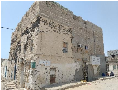
بعض التوليفات بين المواد التقليدية والصناعية يمكن أن تؤدي إلى اضطراب هيكلي شديد، محافظة شبوة، مديرية الرضوم. ٢٠٢٢ © جمعية رعاية الأسرة اليمنية
