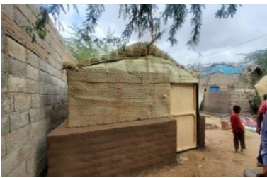
مأوى انتقالي متوسط الامد تجربي باستخدام الجدار الطيني والخزف © جون واين، كتلة المأوى
