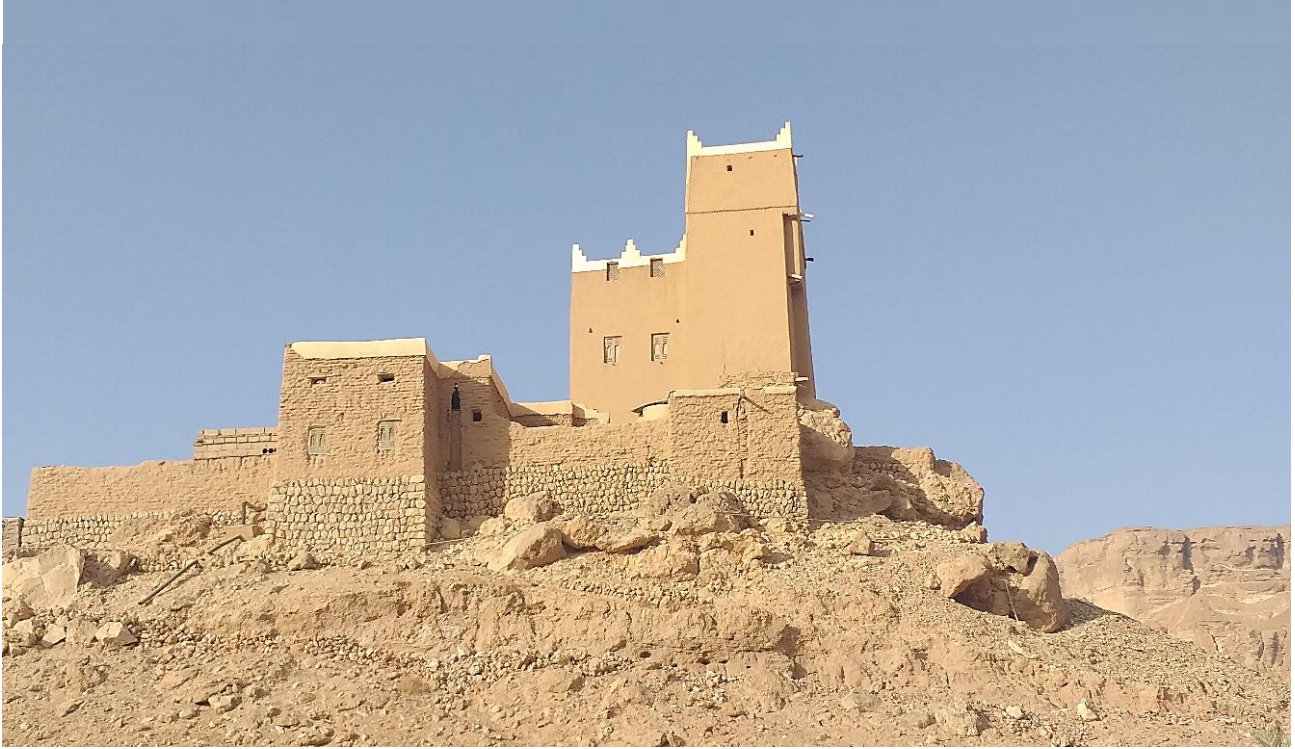
مبنى من الطوب الطيني بقاعدة حجرية، محافظة حضرموت، منطقة الرخية، ٢٠٢٢ © جمعية رعاية الأسرة اليمنية
