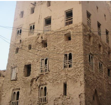
يجب صيانة الجص الطيني بانتظام لحماية واجهة المبنى، شبام © كتلة المأوى
