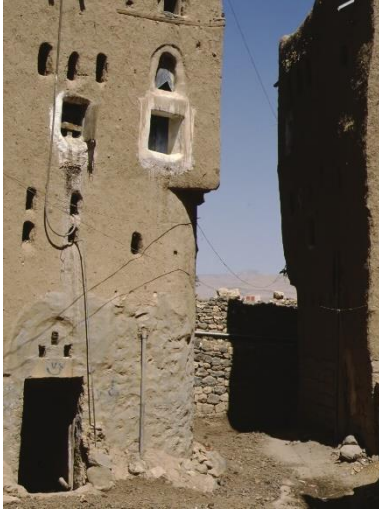
نتوء في زاوية المبنى مما يوسع ممر الشارع، محافظة عمران © المركز الدولي للعمارة
