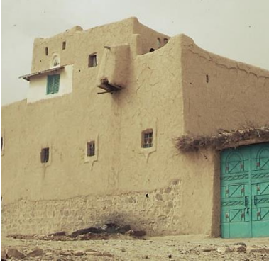
تصريف مخلفات قد يؤثر على الأساس © المركز الدولي للعمارة الأرضية
