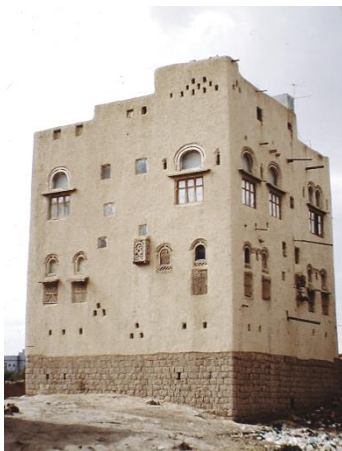
قاعدة حجرية تحمي المبنى من الفيضانات المفاجئة © المركز الدولي للعمارة الأرضية
