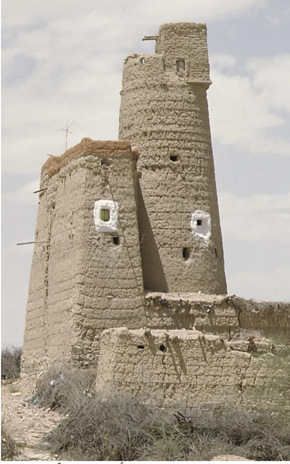
برج حراسة مع غطاء جدار تم إنشاؤه مؤخراً، تقنية جدار الكوب، محافظة عمران © المركز الدولي للعمارة
