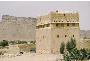
نموذج مضغوط بجدار سميك للحفاظ على البرودة أو الدفء في الداخل حسب الموسم، صعدة © المركز الدولي للعمارة
