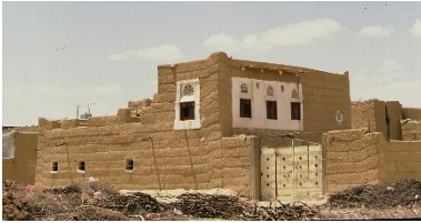
اتجاه المنزل بواجهة صغيرة معرضة لأشعة الشمس، وأسطح بيضاء حول النافذة تعكس أشعة الشمس، لتقليل امتصاص الدفء، عمران © المركز الدولي للعمارة
