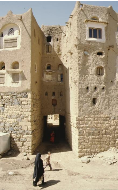
تقنيات المزج، الطوب الطيني مع البناء الحجري © المركز الدولي للعمارة الأرضية
