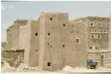
النوافذ الصغيرة مع التوجيه الصحيح للجدار الطيني السميك يضمن مناخاً طبيعياً بالداخل © المركز الدولي للعمارة
