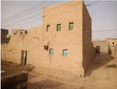
مبنى من الطوب الطيني، محافظة شبوة، مديرية المرخة السفلى، ٢٠٢٢ © جمعية رعاية الأسرة اليمنية
