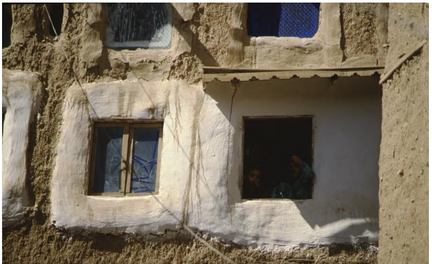
نافذة بإطار من الجبس الجيري المعد مسبقاً © المركز الدولي للعمارة الأرضية
