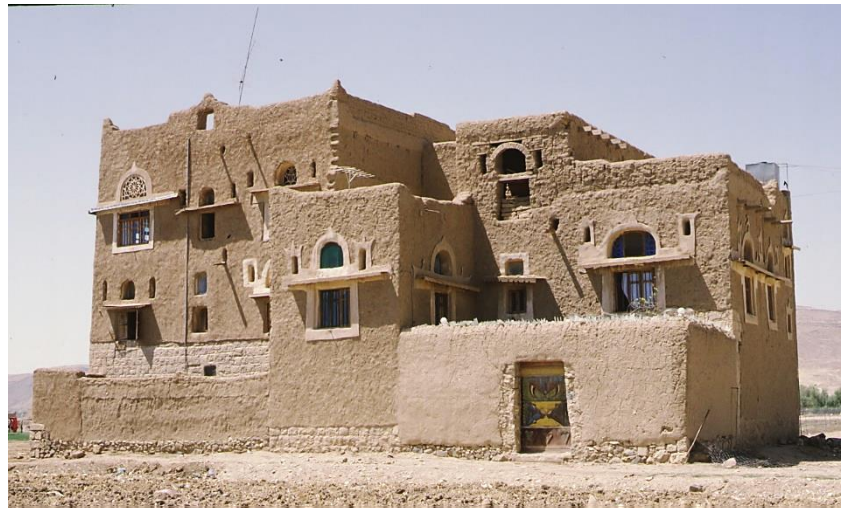
مزيج من جدران الكوب والطوب الطيني والبناء الحجري مع الجص الطيني، محافظة عمران © المركز الدولي للعمارة الأرضية
