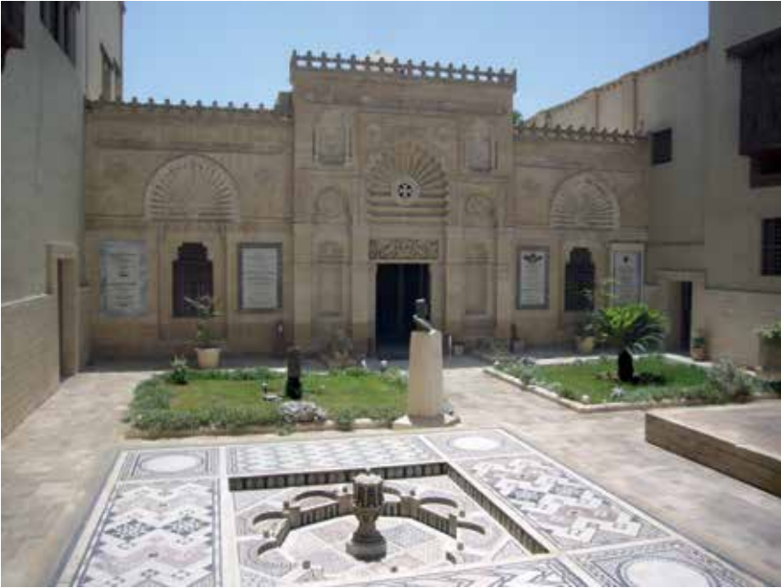
Fig. 3 – Façade de la salle des icônes (actuelle entrée) du Musée copte du Caire élevée à l'époque de Marcus Simaïka Pacha et inaugurée en 1929.
