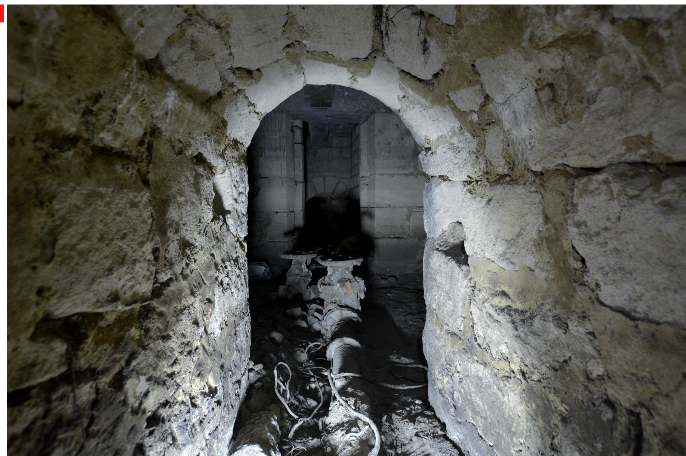
2 Le regard qui permettait l'accès aux conduites pour la maintenance a été arasé en surface pour le nivellement de la chaussée. Les deux canalisations sur lesquelles sont installées des vannes d'arrêt reposent dans un bassin rectangulaire. © N. Samuelian, Inrap
