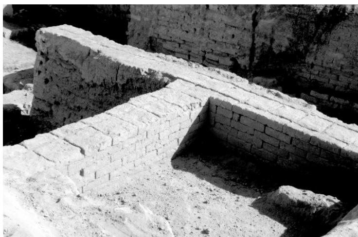
Fig. 17 – Élévation des murs de fondation 10, 36 et 9 avec chaînage, fondement bien assuré et faces bien dressées, dans le carré III H 1 (cl. mission archéologique de Mari).
