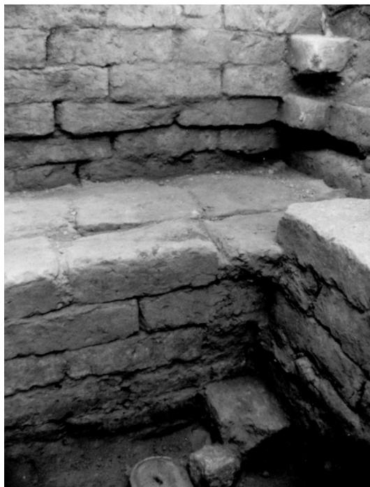
*Fig. 10 – Chaînage bien réalisé entre les différentes composantes des murs de fondation 8-7 et 38-39 du carré III H 1 (cl. mission archéologique de Mari).*
