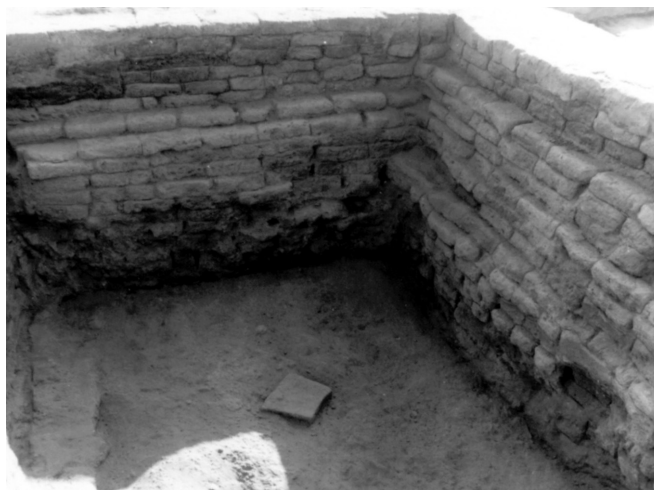
Fig. 19 – Large base d'une fondation avec diminution de l'épaisseur par étapes jusqu'au niveau du sol d'utilisation : murs 41 et 34 du carré III H 1 (cl. mission archéologique de Mari).
