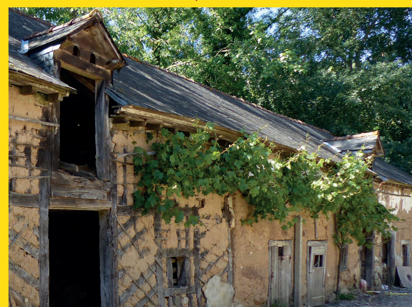
Figure 1. exemple de bâtiments en terre crue : au premier plan pans de bois et torchis sur clayonnage, au second bauge ». Ne pas mettre « ferme » car ce sont des communs d'un château. Communs du château de Ville-au-Sénéchal, Irodoüer, 35).
