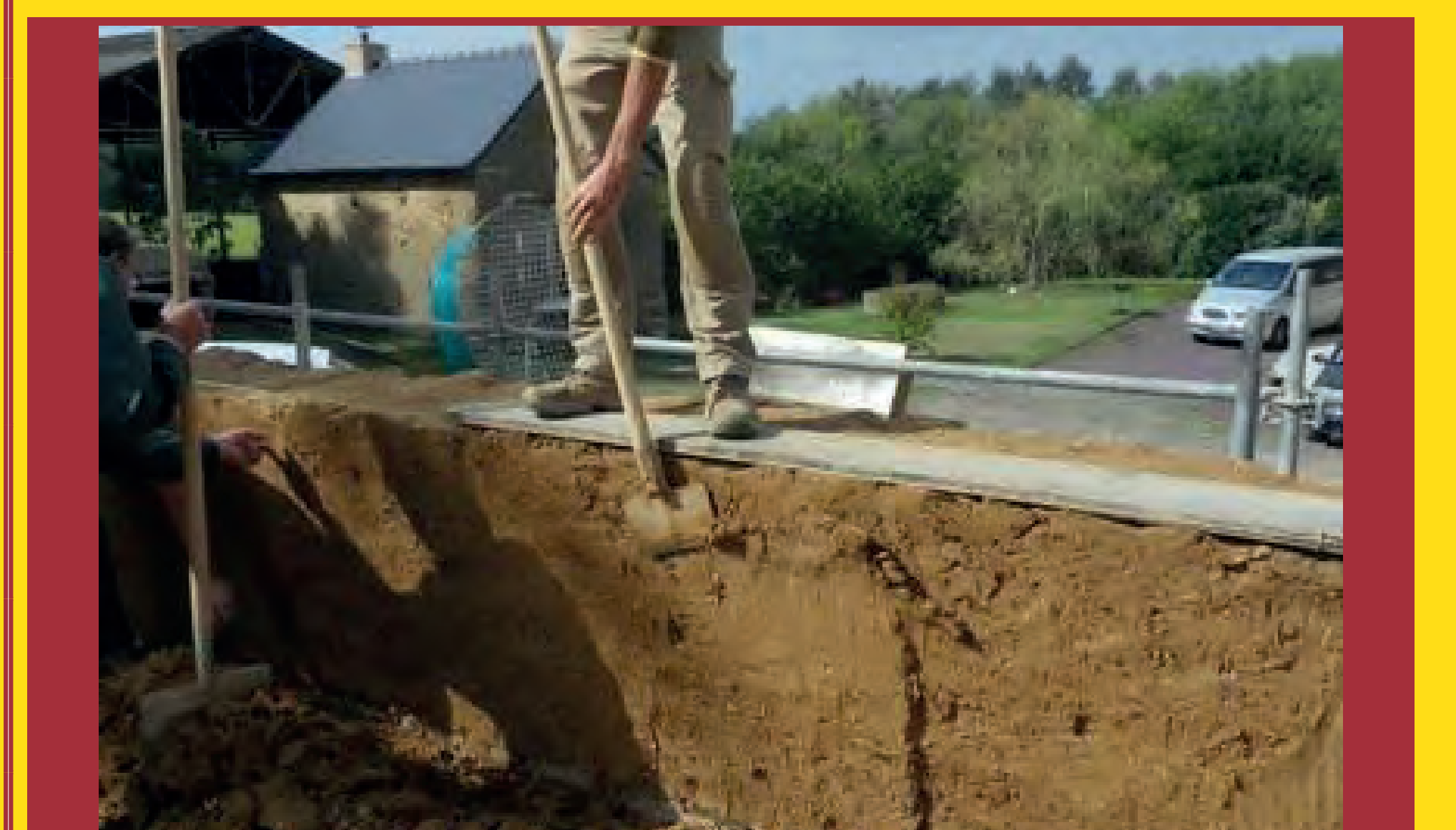
Lors des dernières journées du patrimoine à la Frinière à Cesson-Sévigné, près de Rennes (35). Démonstration du montage d'un mur en bauge. Ici le maçon utilise sa paroière pour rectifier la verticalité de sa levée.
