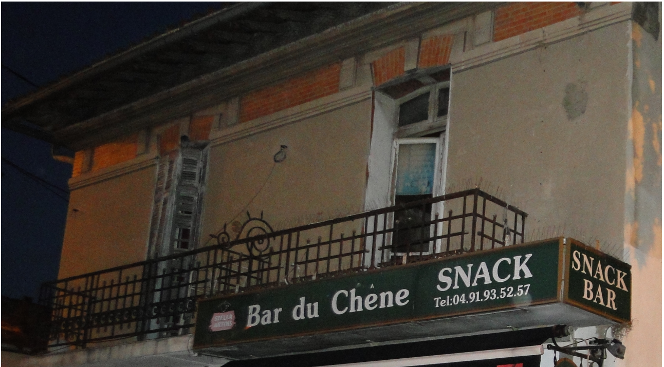
État actuel de l'immeuble Stripoli-Moccia à Beaumont (détail du premier étage). Entablement en briques et ciment réalisé en 1906. L'établissement du rez-de-chaussée a conservé le nom de « Bar du Chêne »
