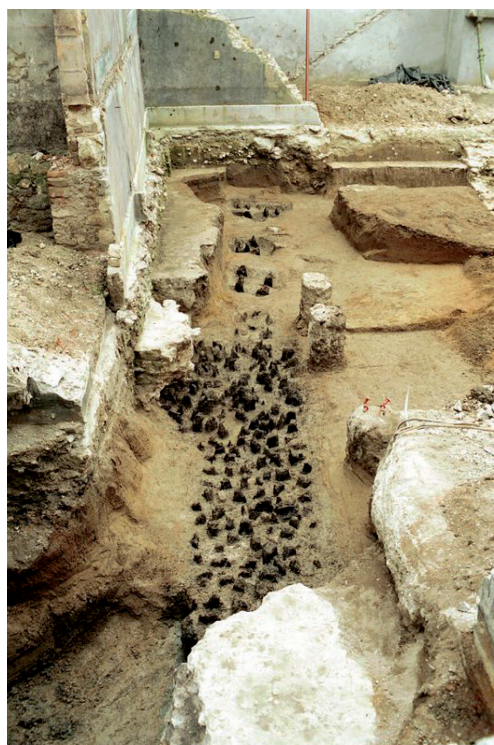
7. Nicolas Fouillet, Pieux de fondation en chêne sur le site des thermes du Lycée Descartes à Tours, 2001, tirage papier, Inrap.
