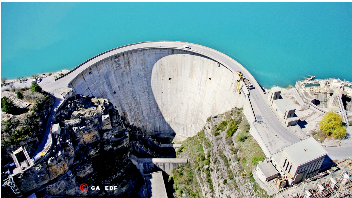
Fig. 1 : Parement aval du barrage de Castillon avec l'ombre incurvée de la corniche. Sur la droite de la photo se trouve l'évacuateur de crue.
