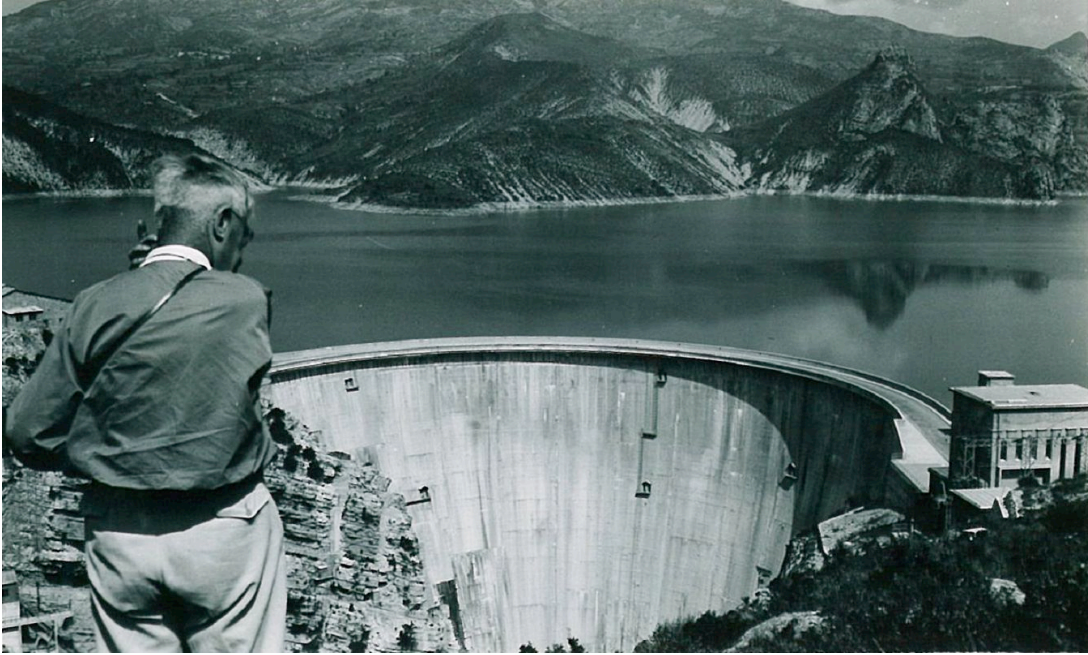
Fig. 28 : André Coyne photographié de dos devant le barrage de Castillon le 4 juin 1952. C'est grâce à l'examen de l'ombre incurvée de la corniche que cette photo a pu être horodatée : il est 9 h 58 m temps légal.
