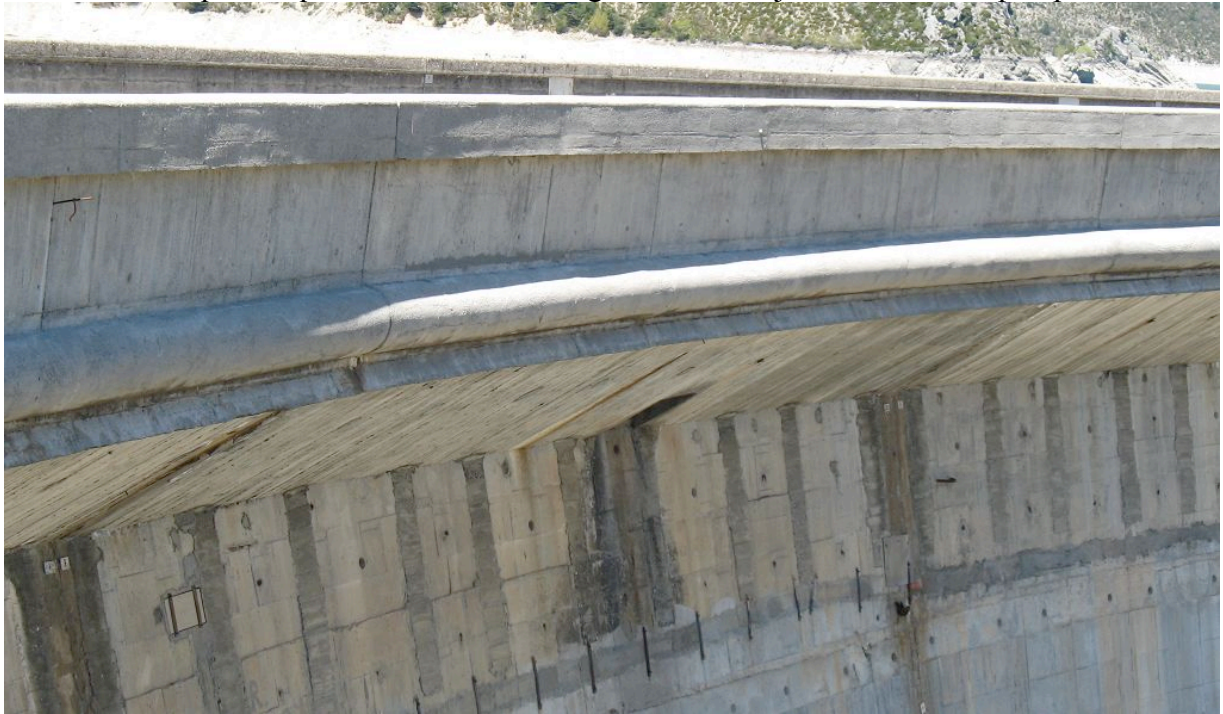
Fig. 13 : Détail de la corniche du barrage. Du niveau zéro du barrage part un plan incliné au-dessus duquel se trouve la partie du tore puis au-dessus le parapet. On voit ici l'ombre du parapet se projeter sur le tore à gauche tandis qu'au milieu il commence à être éclairé. Cela signifie que sur la voûte du barrage, une partie de l'ombre est due au parapet, l'autre au tore.
