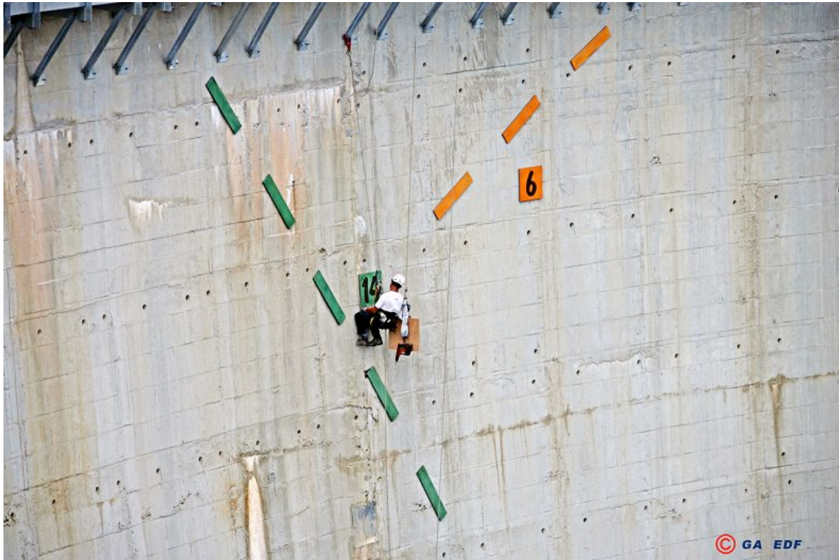
Fig. 31 : Alpiniste en plein travail sous la passerelle d'accès. Il scelle sur le parement les blocs de lave émaillée ainsi que les plaques sur lesquelles sont inscrits les chiffres des heures.
