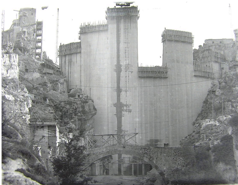
Fig. 5 : Le barrage en construction en 1948 vu de l'amont. Au premier plan se trouve le pont qui enjambait le Verdon.
