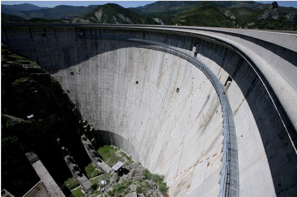
Fig. 32 : Le cadran solaire terminé photographié avec un grand angle depuis la culée Est. Les lignes horaires ont des couleurs différentes pour le matin (ocre) et l'après-midi (vert). Sur la photo il n'est pas encore 13 h solaire.
