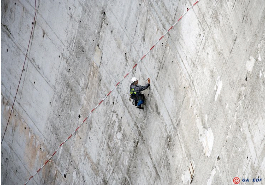
Fig. 29 : Alpiniste en plein travail sur le parement du barrage : il inscrit à la surface le point d'implantation d'une ligne horaire temporaire indiqué par un viseur laser situé sur une des rives.
