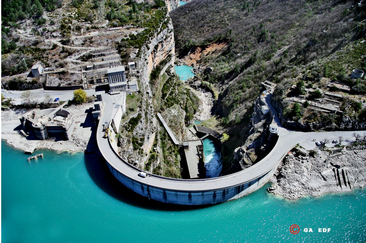
Fig. 2 : Parement amont du barrage de Castillon. Au pied du barrage se trouve l'usine hydroélectrique d'où s'échappe l'eau du Verdon.
