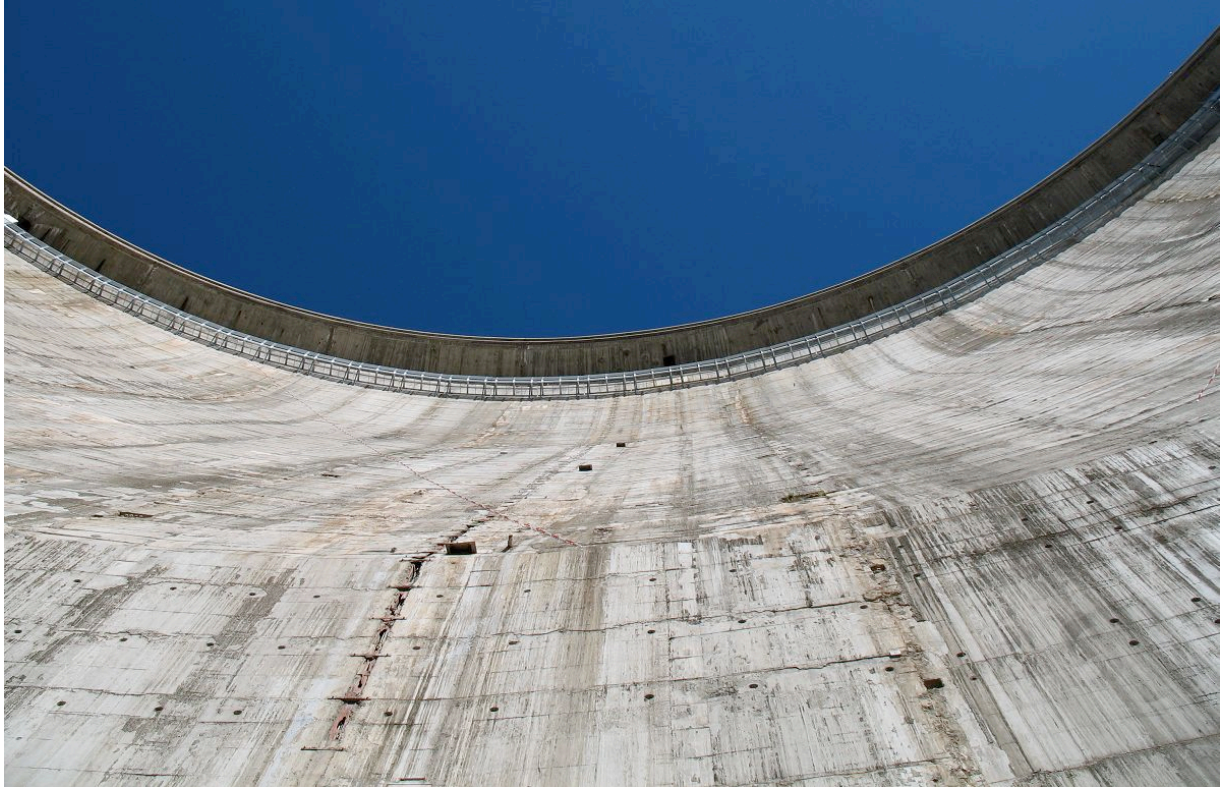
Fig. 4 : Photo prise depuis le pied du barrage. Au premier plan se trouve la partie cylindrique ; on distingue bien un peu plus haut la « rupture » entre la partie limaçon de Pascal et la partie parabolique.
