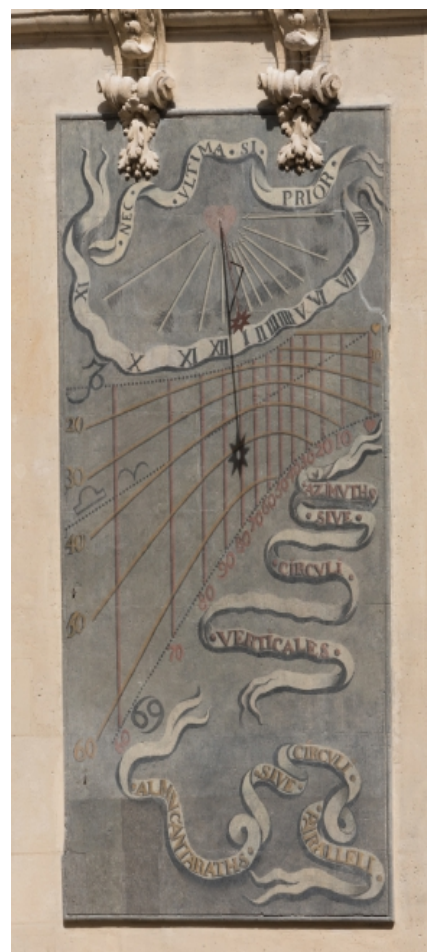
Fig. 27 : Panneau 4 terminé avec son tracé moderne et son style polaire installé.
