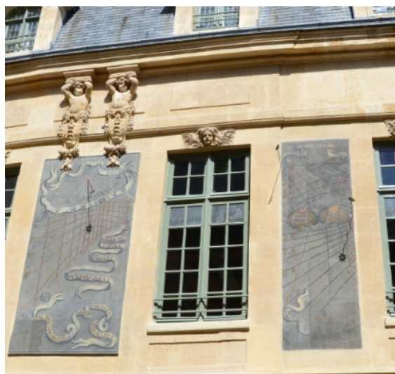
Fig. 2 : Façade Sud-Ouest de l'Hôtel Amelot de Bisseuil avec ses deux panneaux où sont peints trois cadrans solaires qui donnent la durée des jours et des nuits ainsi que les coordonnées horizontales du Soleil.
