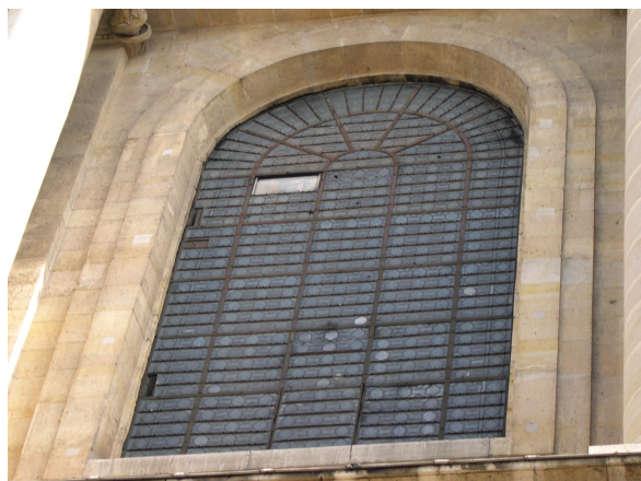
Figure 10 – Vue extérieure du vitrail Sud de l'église St-Sulpice. On voit nettement sur la gauche les deux entrées qui font office d'œilleton. Une corniche située au-dessus du vitrail projette une ombre en été qui empêche la lumière de pénétrer dans l'œilleton du haut. D'où la nécessité qu'a eu Le Monnier d'installer un deuxième œilleton un peu plus bas.
