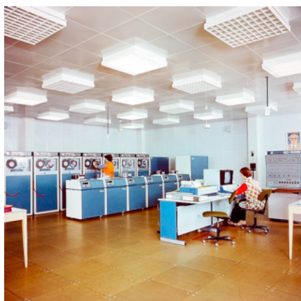
Fig. 4. Ordinateur moyen soviétique ES-1035 dans un centre de traitement en URSS (vers 1983).
