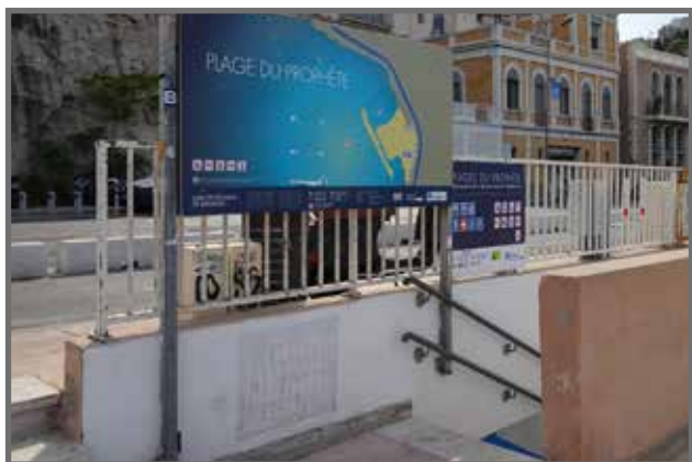
Fig. 35 - Entrée nord, vue depuis la corniche
