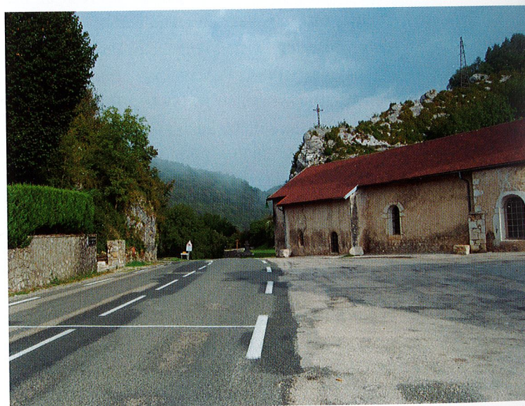
Figure 3 : Izernore. Les Portes de Fer. Vue du côté du plateau, à droite la chapelle (photographie J.-R. Le Nézet)
