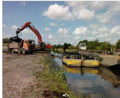
Plateforme de chargement des camions
