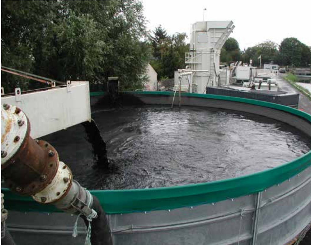
Figure 3 : Installation de séparation liquide/solide de sédiments dragués
