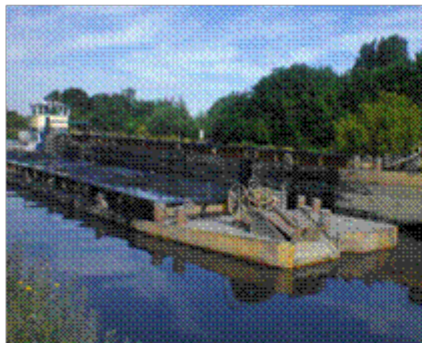
Pousseur de barge (environ 500 m 3 de boue de dragage)
