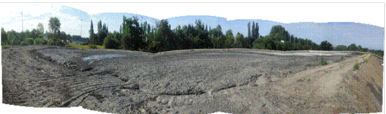
Vue panoramique du site de dépôt [vers Loison-sous-Lens]
