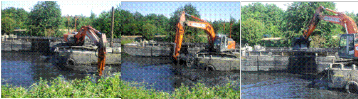
Mouvement de la pelle sur le ponton et extraction des sédiments dans le canal
