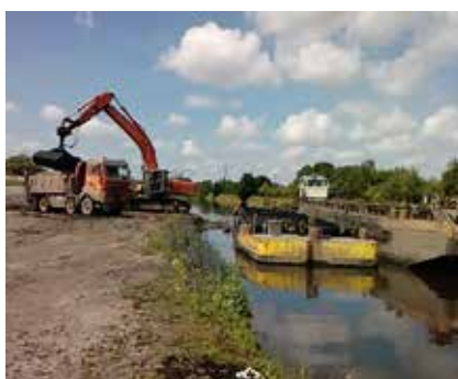
Plateforme de chargement des camions
