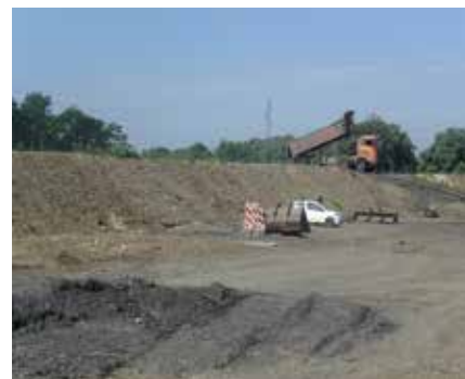
Déchargement du camion (environ 20 m 3 ) dans le site de dépôt
