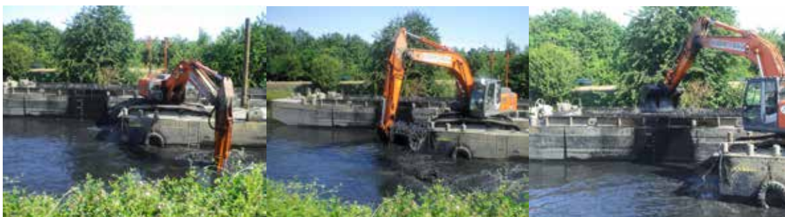
Mouvement de la pelle sur le ponton et extraction des sédiments dans le canal
