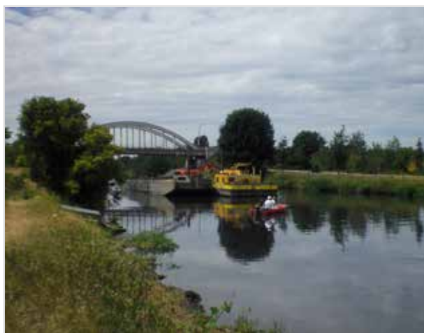
Position du chantier au début des prélèvements et les mesures
