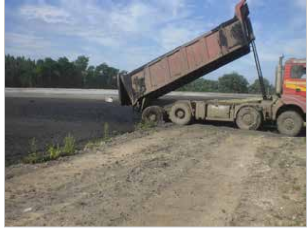
Déversement des boues de curage dans l'alvéole de dépôt
