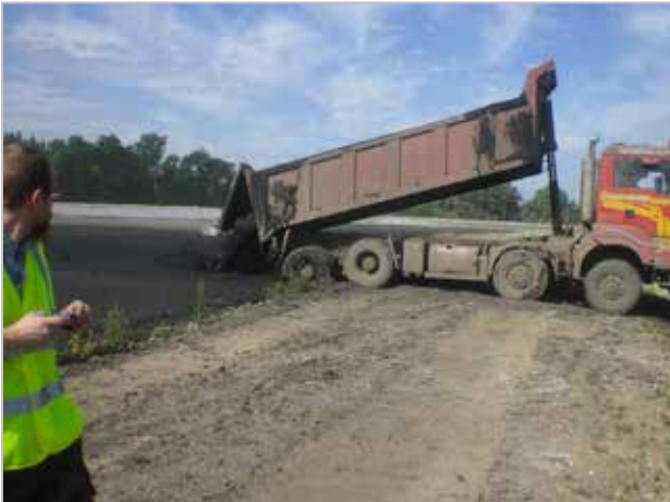
Déversement des boues de curage dans l'alvéole de dépôt
