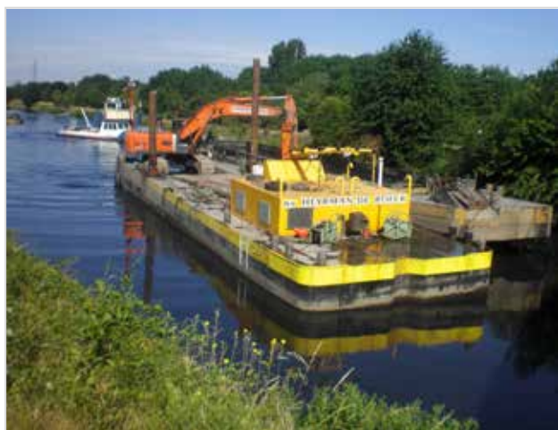
Position du chantier avant les prélèvements et les mesures
