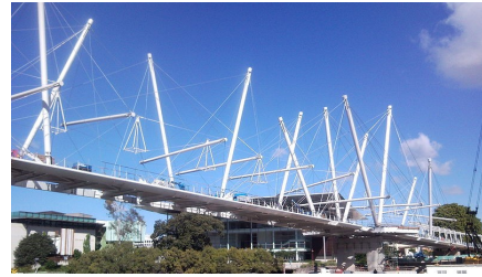
FIGURE 5 – Pont construit sur le principe de tenségrité : le Kurilpa Bridge de Brisbane
