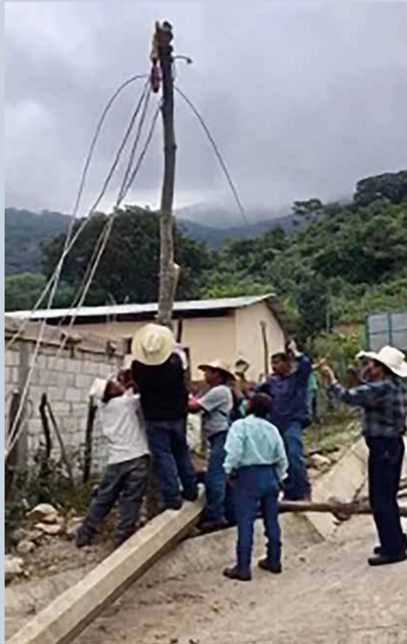
4-5. Un groupe d'acti- vistes en train de hisser (4) et fixer (5) des poteaux élec- triques auto- produits (en bois, 4; en béton, 5).
