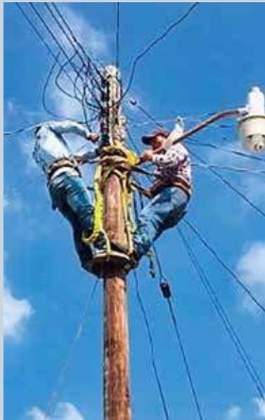
6. Deux électriciens travaillant sur la ligne basse tension, pour raccorder plusieurs foyers au réseau électrique. Municipalité de Ocosingo, Novembre 2019.
