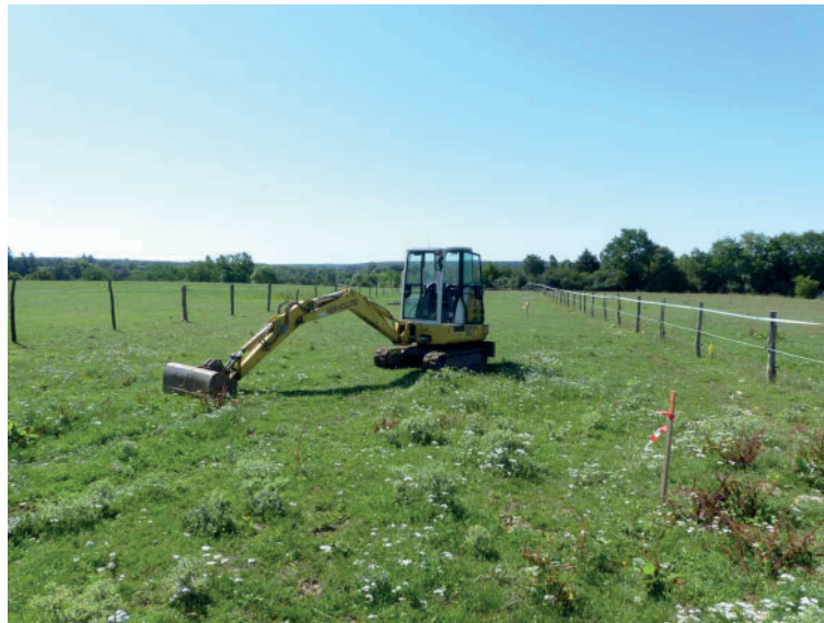
Figure n°86. La pelle hydraulique utilisée pour l'excavation des sondages (St. Venault).
