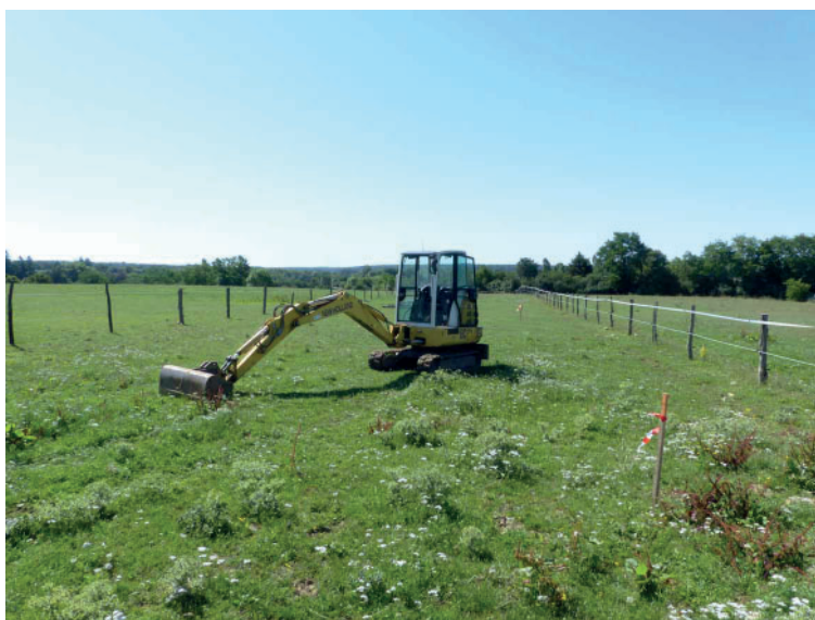
Figure n°86. La pelle hydraulique utilisée pour l'excavation des sondages (St. Venault).
