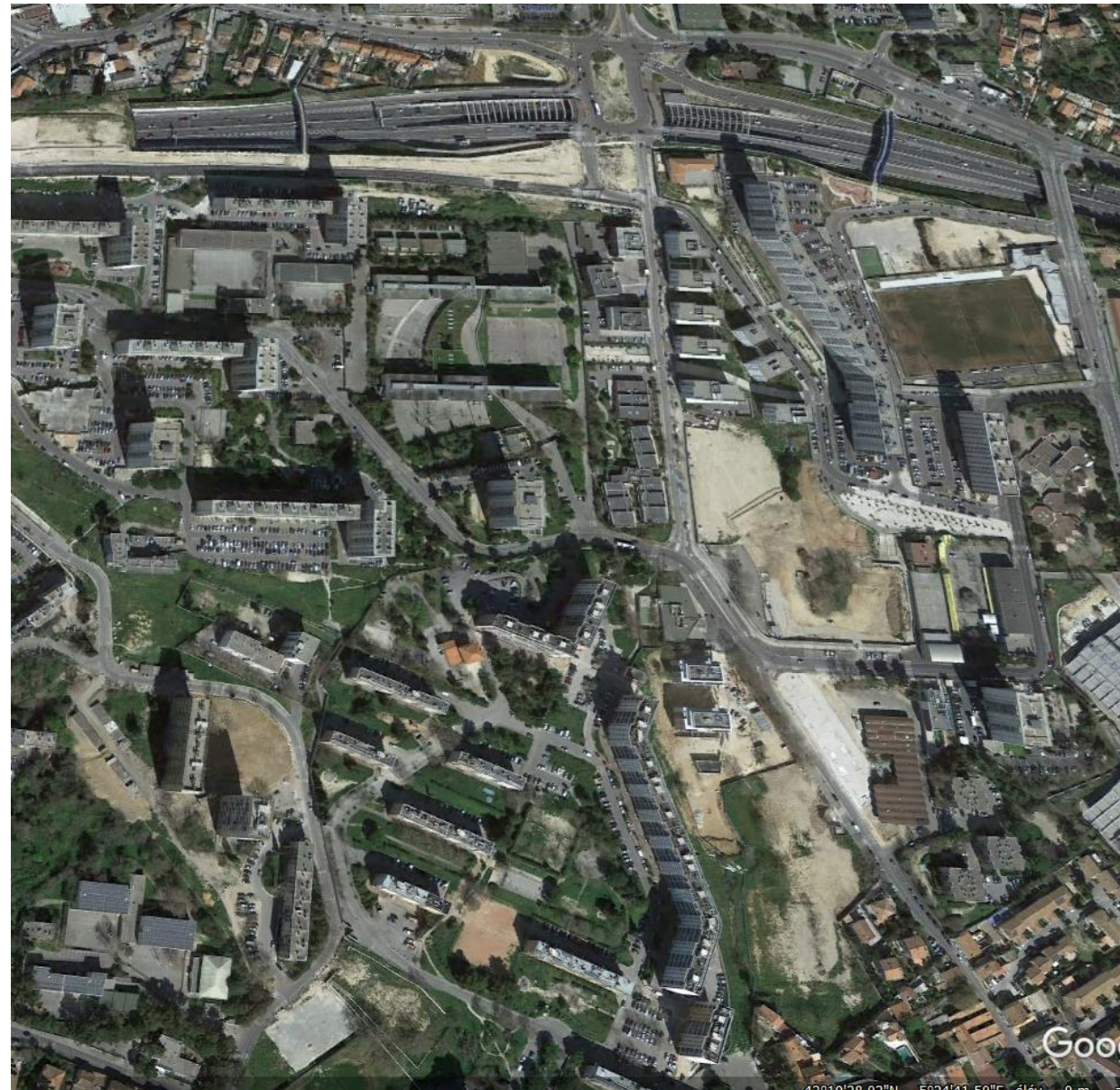
Cadre de vie en zone de concentration d'ensembles sociaux en cours de densification, Marseille nord
