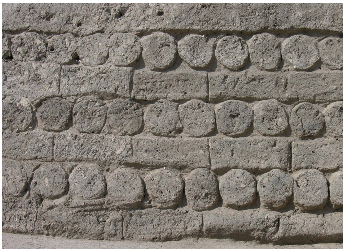
fig. 1 Fondations en briques cruées de forme cylindrique. © Mission franco-égyptienne de Tell el-Herr.
